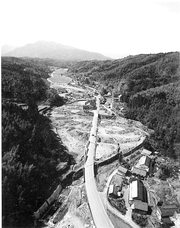
富貴寺遺跡(東地区)遠景
