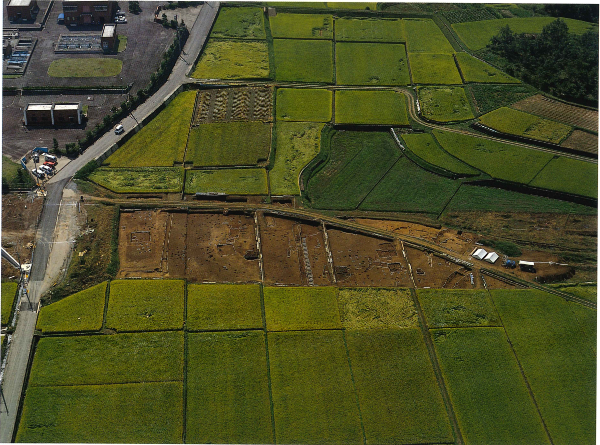
野間地区：全景（北から）
