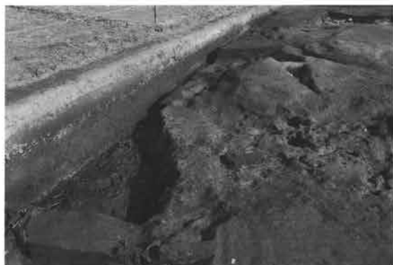
5区53号溝 (南西より)
