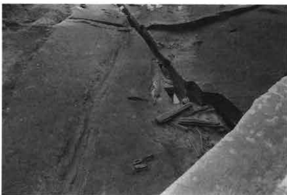
3区As-C下A・F地点近接(北東より)
