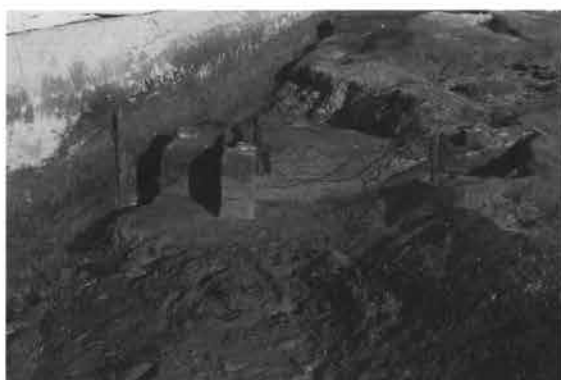
5区1号河道杭列 (南西より)
