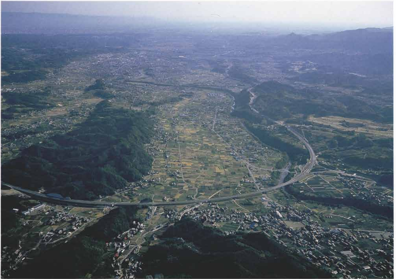
甘楽の谷を西方から望む（右手前下仁田インター、遠方は関東平野）
