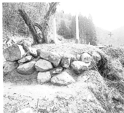
3. 西側石垣の北端部 (西から)
