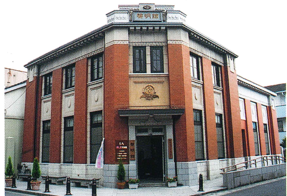
隈まちづくりセンター黎明館
