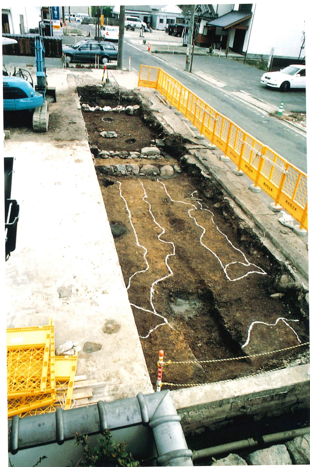
5区 遺構検出状況（西から）
