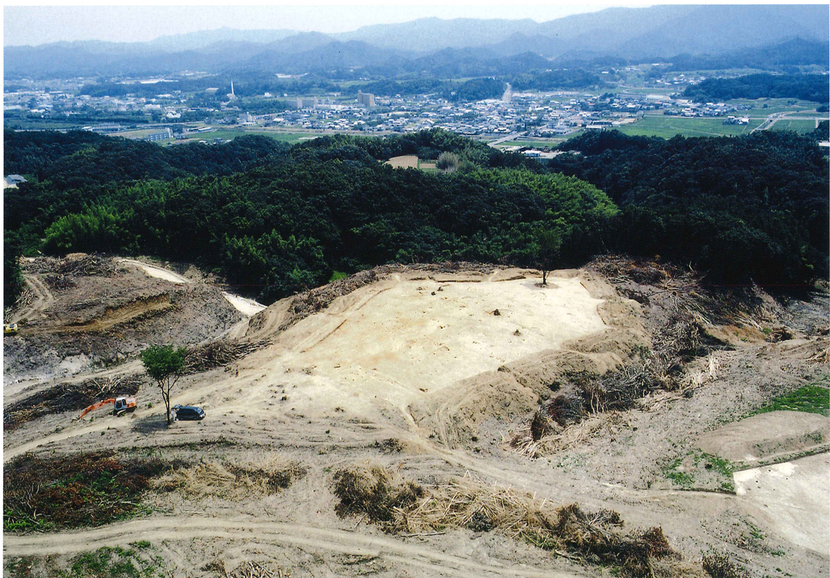
善福寺2地区（北西から）
