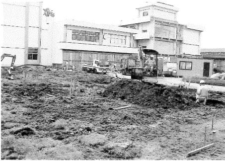
写真8 立会調査状況（管理棟・普通教室棟）
