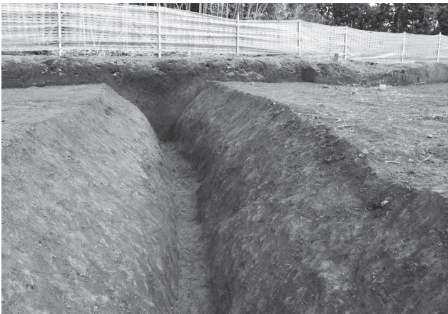
SD001 V字溝近景 (南西から)
