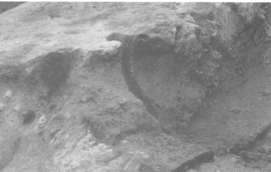
2. 焚口初期窯壁 (南壁)
