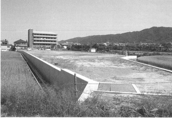
調査前(南西から)
