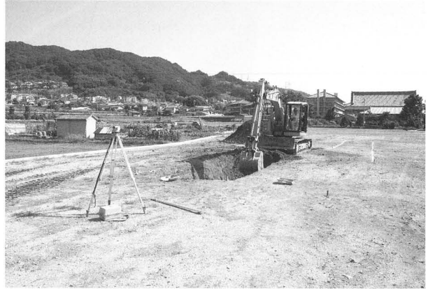
機械掘削状況(北西から)
