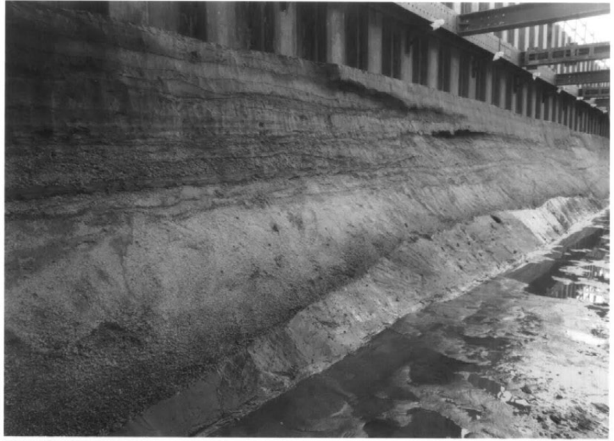
南壁地層断面 (北東から)
