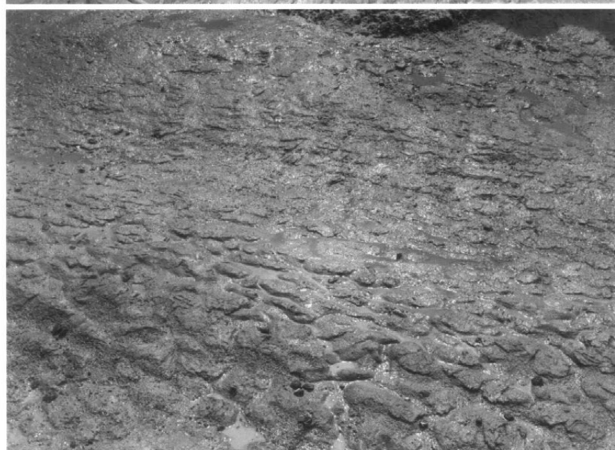
NR1301底面の 侵食痕跡(2) (南西から)
