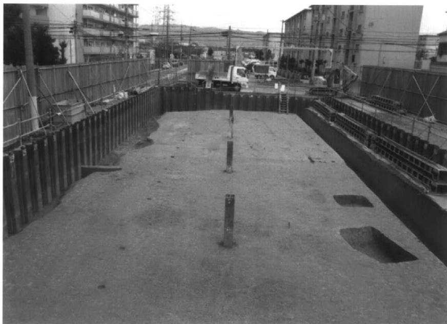
第4層上面検出状況 (西から)
