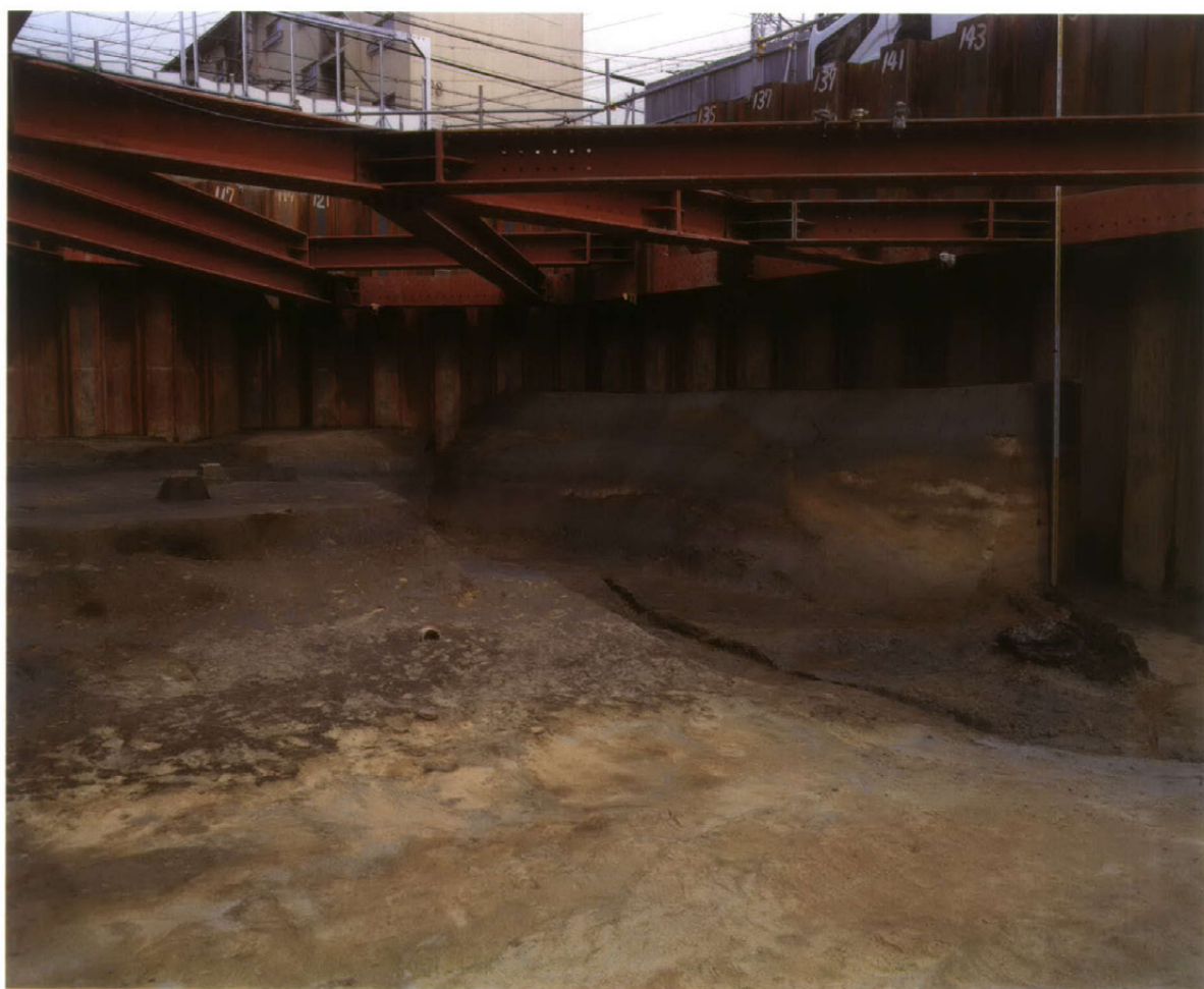
NG05-3 次南東隅南壁第10~31層地層断面(北西から)
