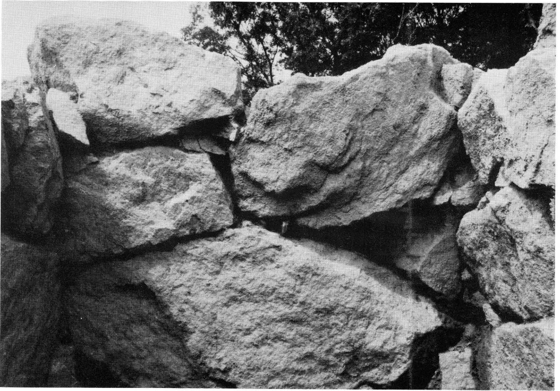
3号墳奥壁（南西から）
