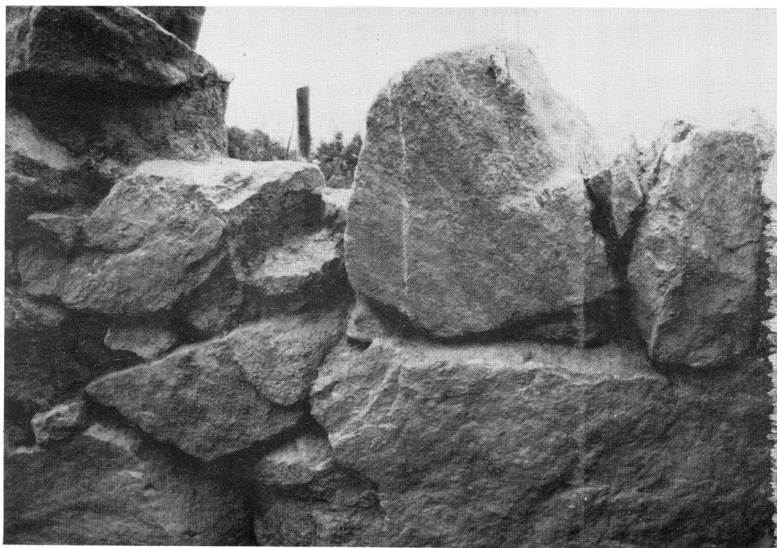
3号墳側壁 奥壁→羨道部（北東から）
