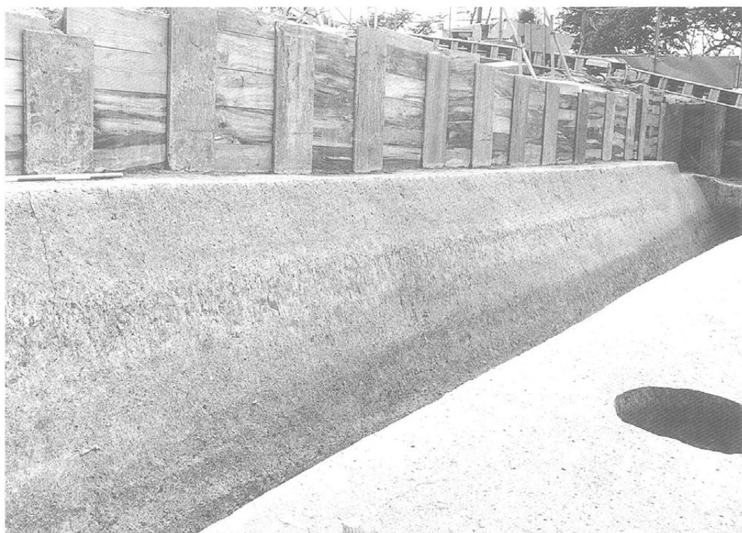
西壁地層断面(東南から)
