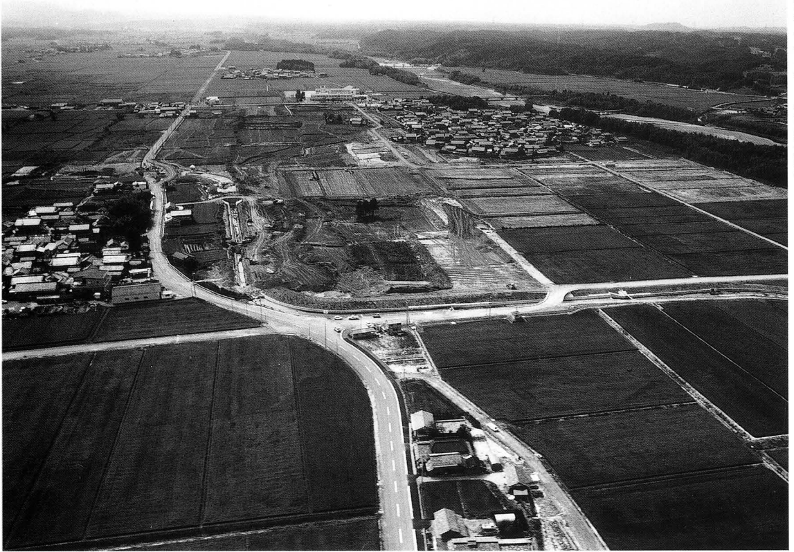
堂田遺跡遠景(北から)
