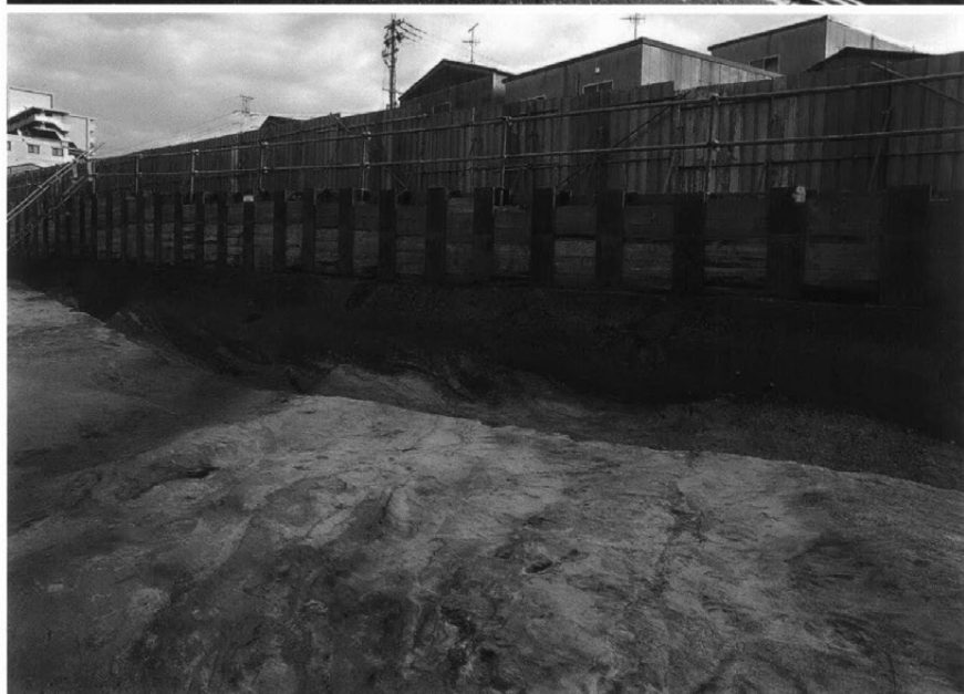
NR601断面 (北西から)
