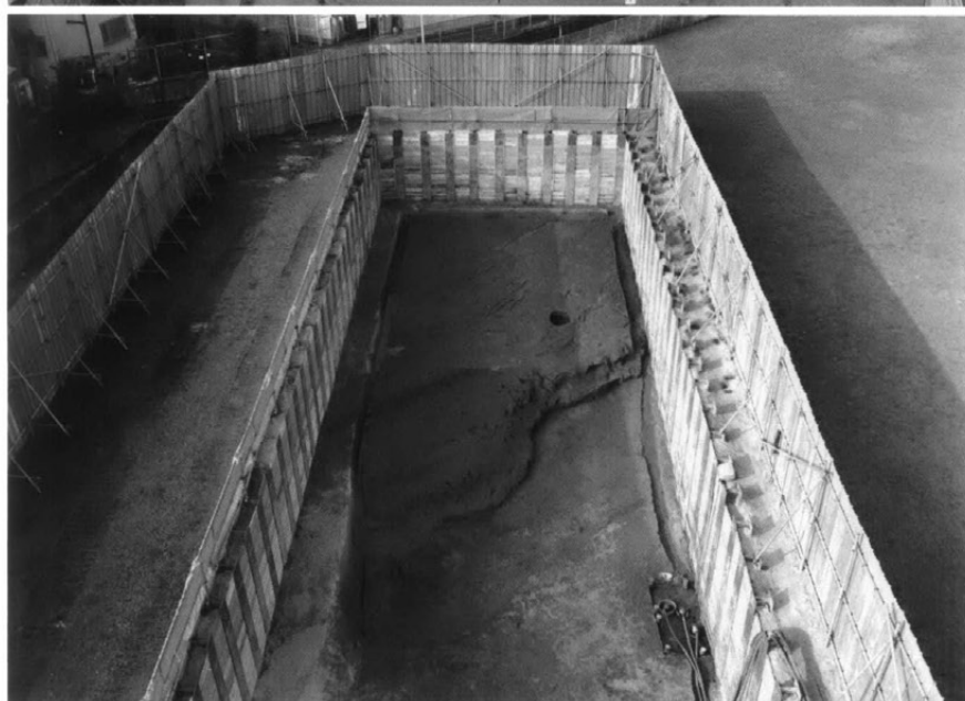
第7層による第8層以下の の削り込み (東から)
