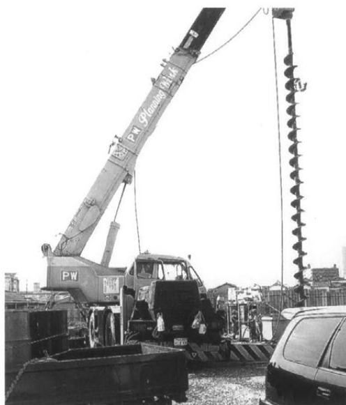
写真1 土留作業風景
