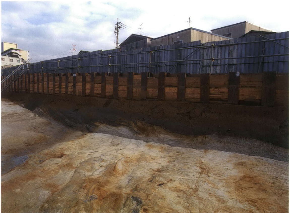
NR601断面(北西から)
