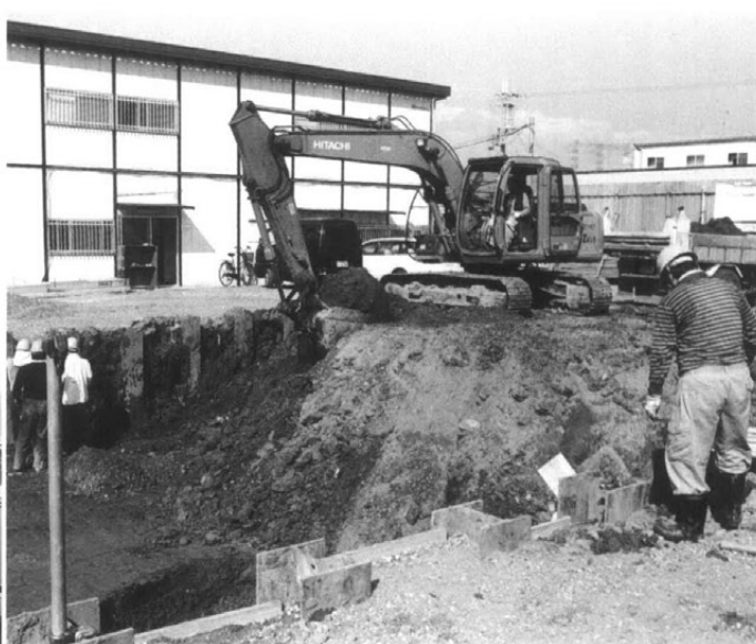
写真2 重機掘削風景
