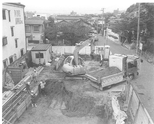
ショベルカーによる表土剥ぎ
