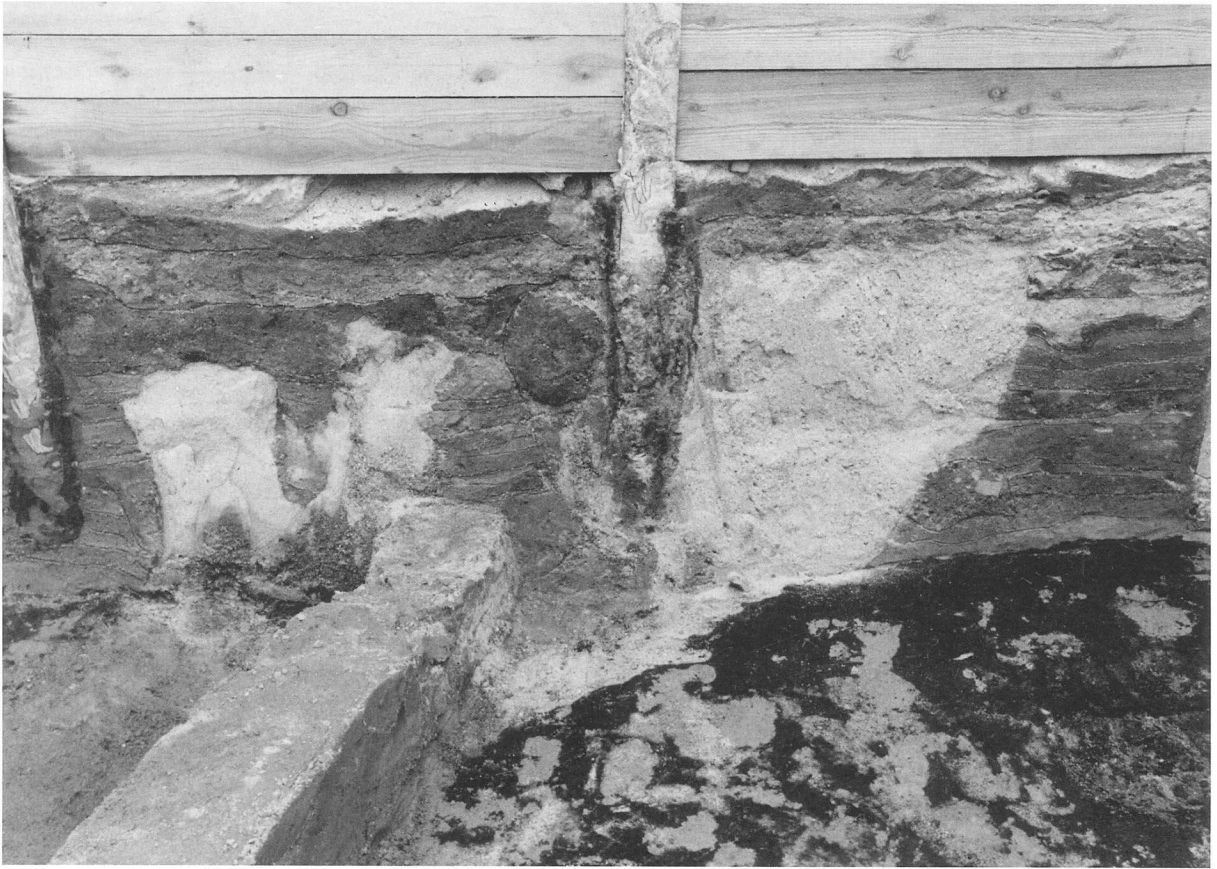
西壁断面に現れた噴砂(地震痕跡)
