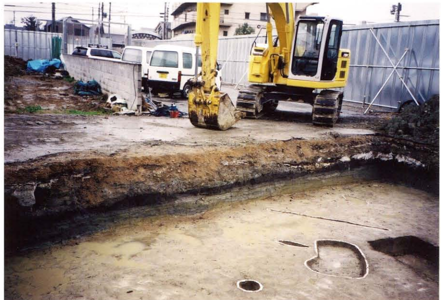
F区調査区西壁断面（南東から）
