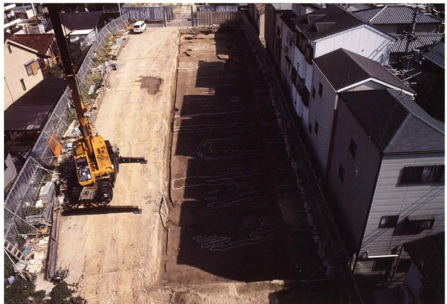
B区第4面 (西から)
