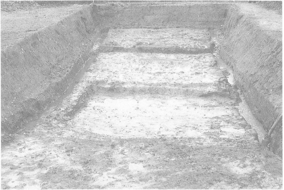
2 トレンチ掘込状況
