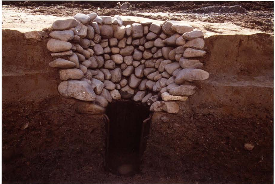
c. 06-3区石組井戸 53 立面 (南から)
