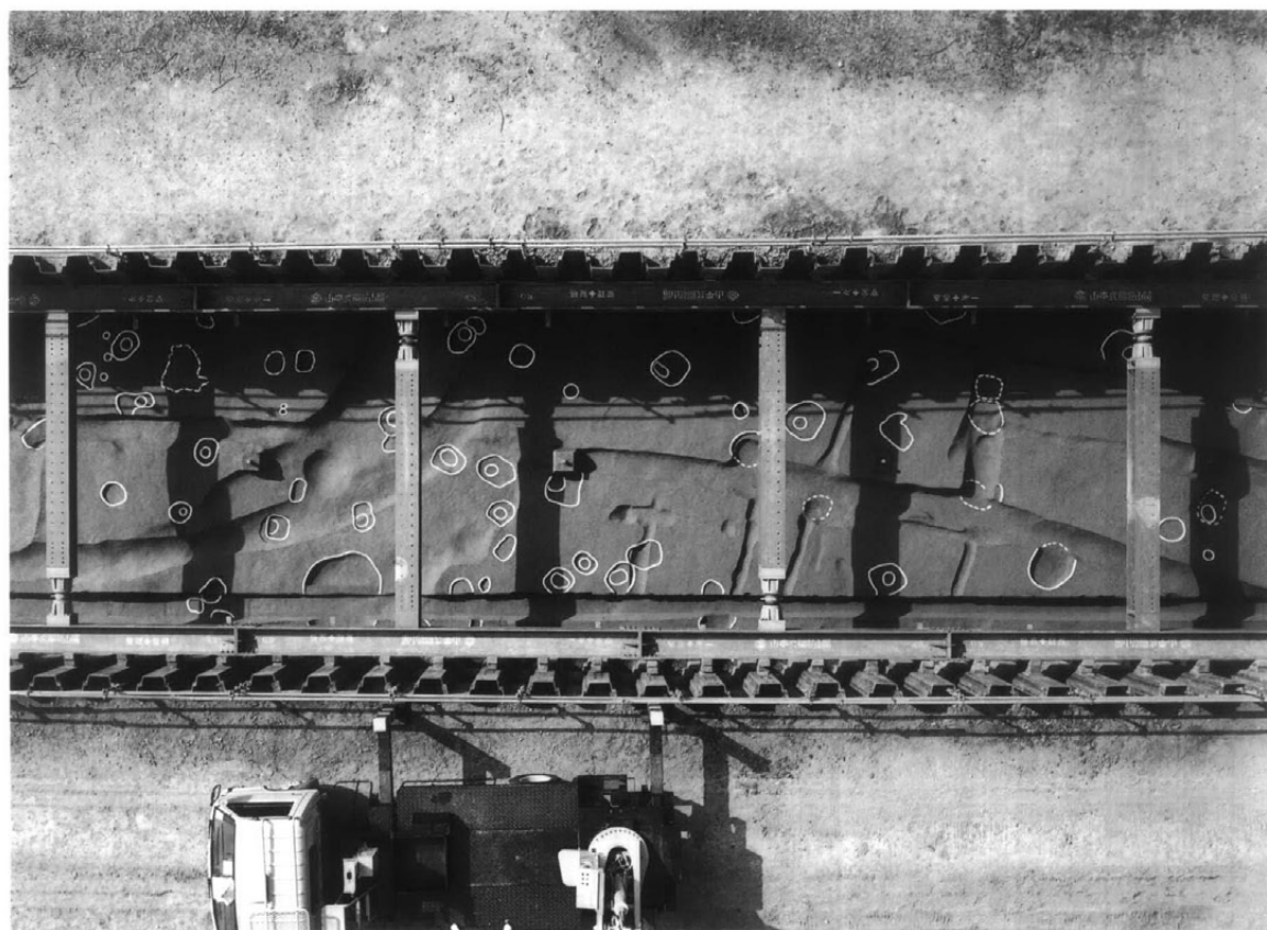
同上 近景（SB603など；上から）
