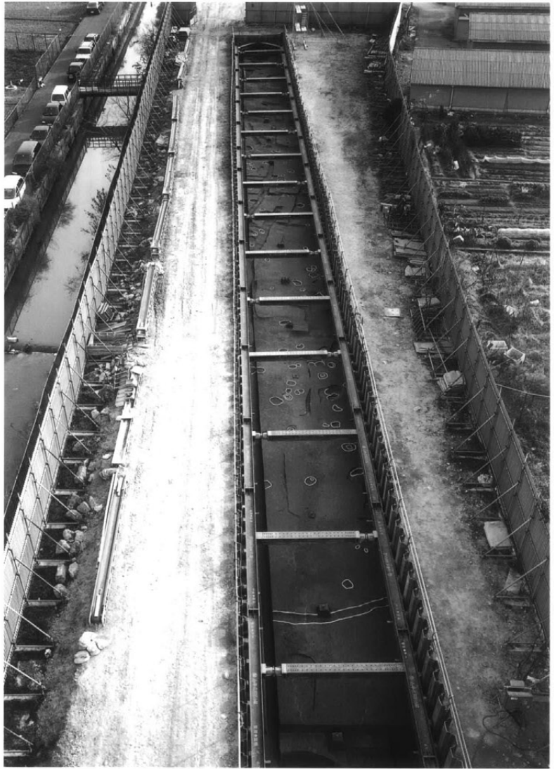
RK5-6層内検出遺構 全景(北から)
