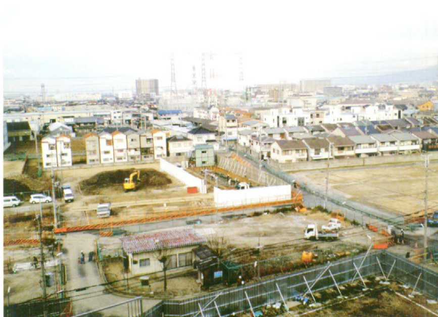
調査地遠景 (南西から)
