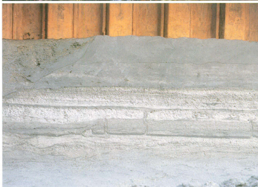
西壁中位の地層断面 (地震による噴砂が 見える、東から)
