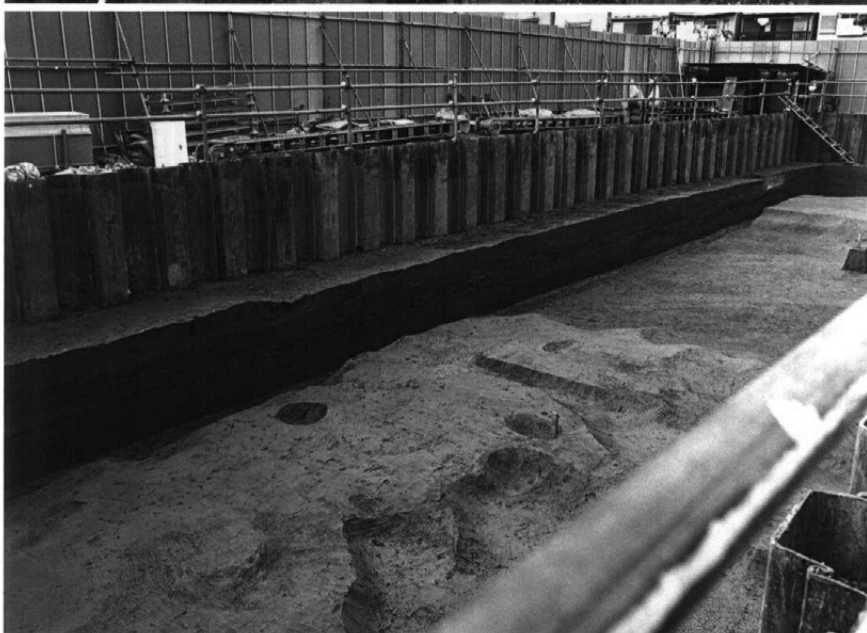
西壁断面 (第3-2層まで、 南東から)
