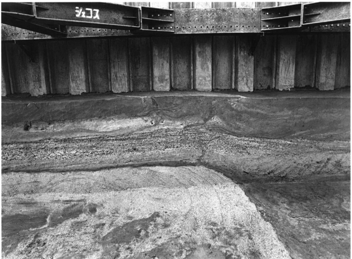
西壁に残る地震の痕跡(噴砂、撓み、東から)
