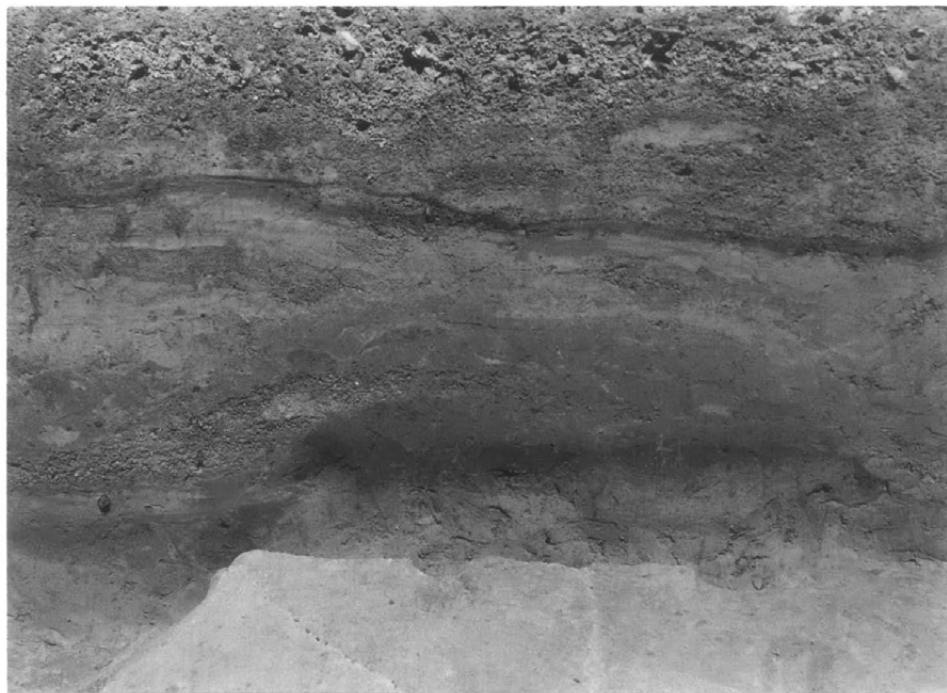
I区SD601堤状盛土 東壁断面
