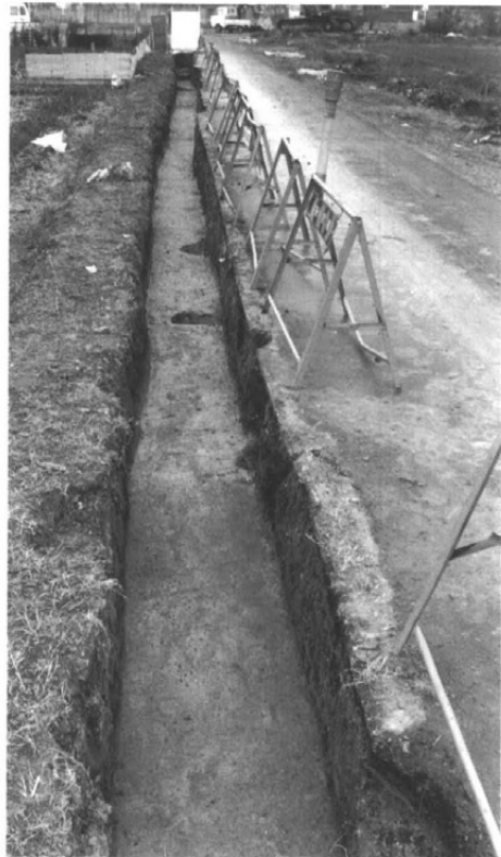
写真1 87-64次(Ⅲ-A区)調査トレンチ
