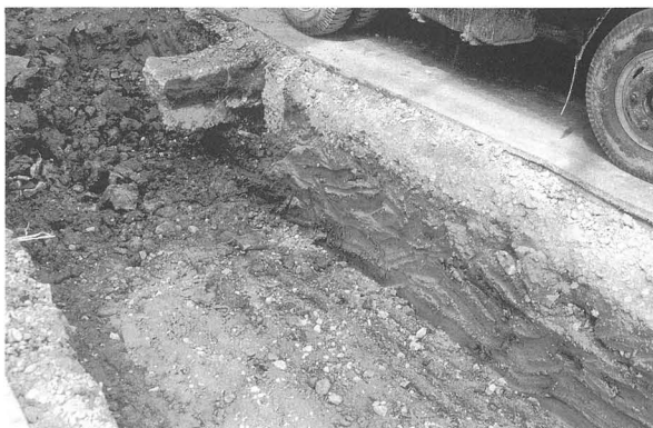
図98 共通教育校舎新管配管埋設工事立会調査
