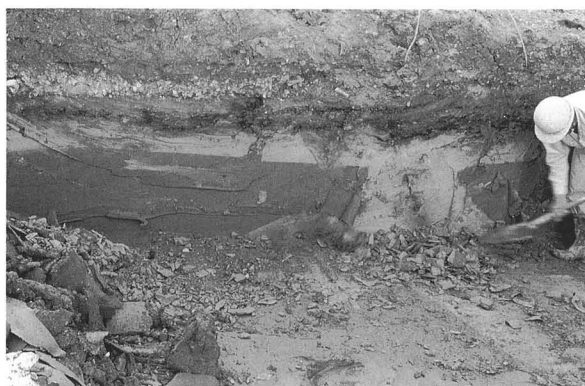
図84 文学部美学棟エレベーター工事立会調査
