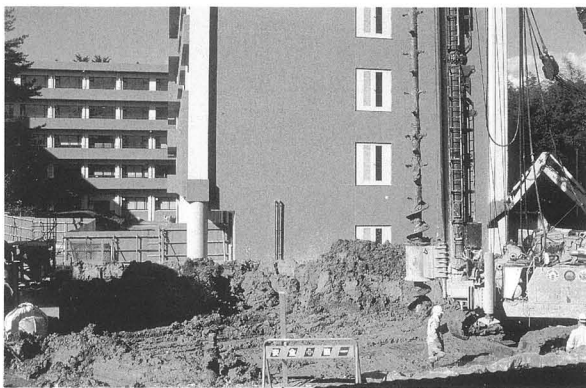
図81 教養部校舎建設工事立会調査
