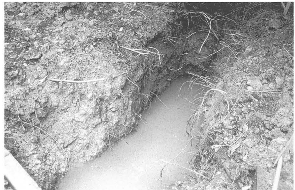
図101 配管工事（基礎工学部北側）立会調査
