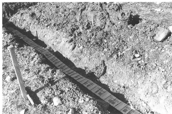
図109 旧医療技術短期大学跡地内駐輪場設備工事
