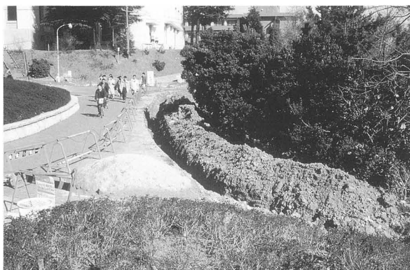
図89 災害復旧（中山池周辺）工事立会調査
