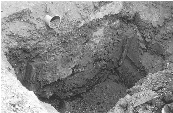
図87 共同配水管設備工事立会調査
