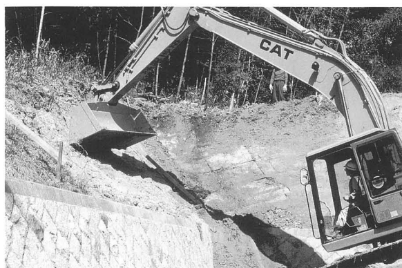
図76 教養部物理学棟裏法面補修工事立会調査
