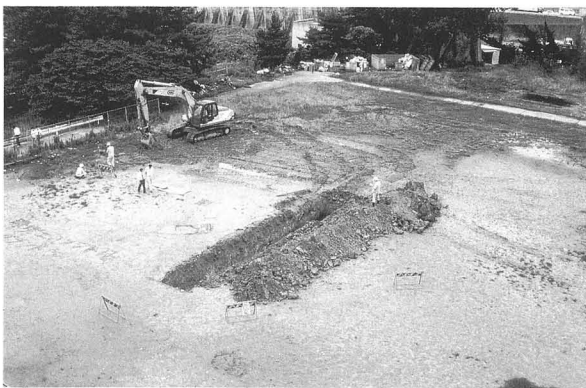
図82 理学部宇宙物理科校舎建設工事試掘調査
