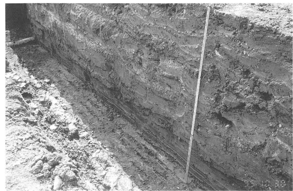
図94 配水管敷設工事立会調査
