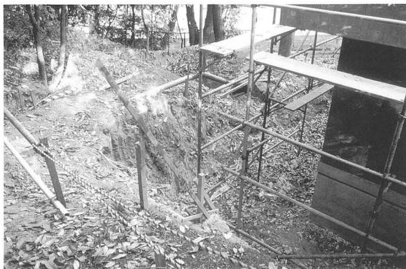
図73 共同溝ステーション立会調査
