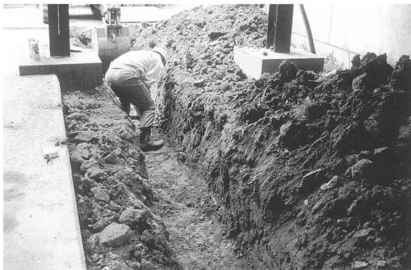
図88 井水配管及び給水管改修工事立会調査
