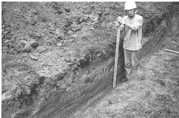
図95 文法経棟中庭プレハブ建設工事試掘調査
