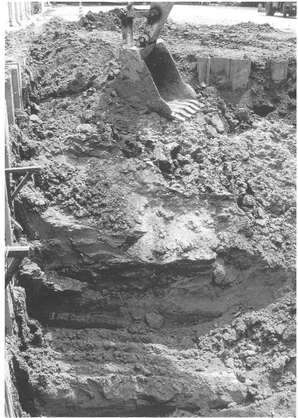
図100 共同溝工事立会調査
