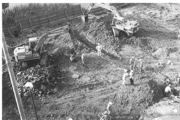
図78 言語文化研究科校舎建設工事立会調査
