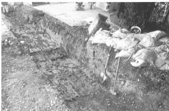
図96 図書館本館西側入口前掘削工事立会調査
