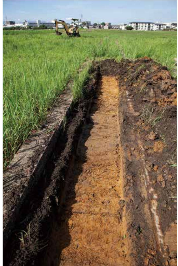
Tr327 古代道路側溝 (東から)
