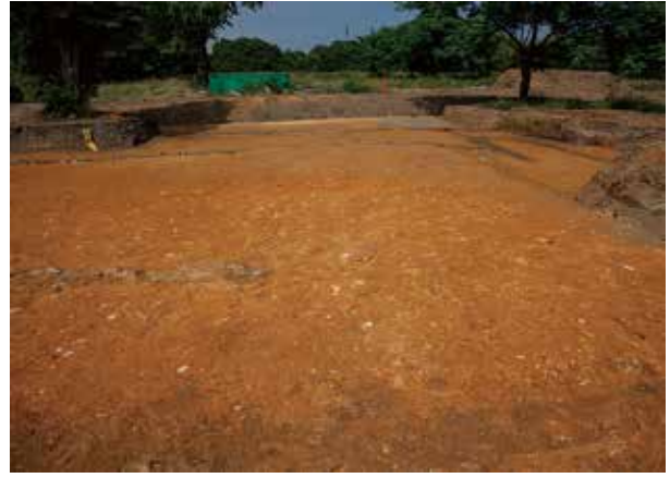
② Tr305 地山削平 (東から)
