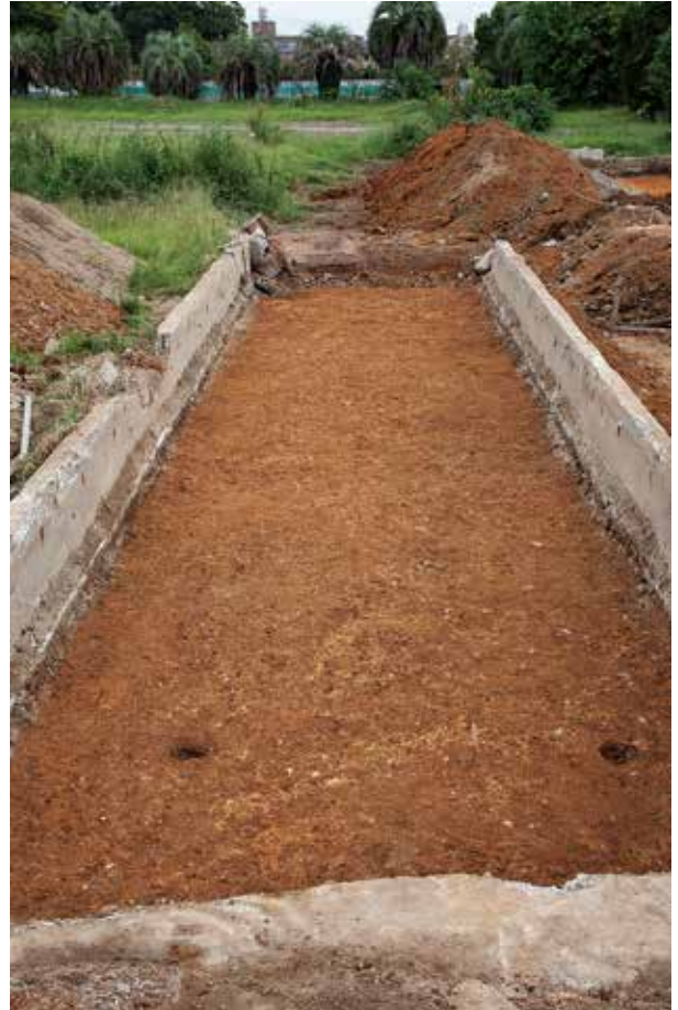
Tr300 地山削平 (北から)
