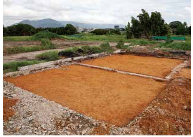
Tr290 地山削平 (北西から)
