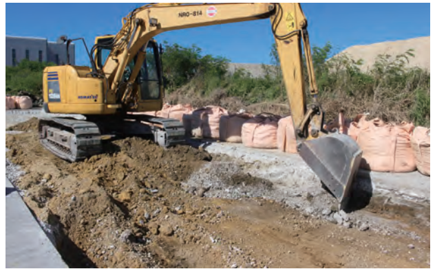
調査区機械掘削状況
