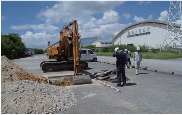
試掘調査状況
