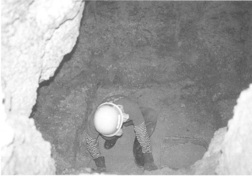
清掃作業の状況
