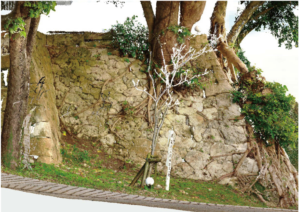
巻首図版4 御茶屋御殿跡の石積状況 上：写真撮影による石積B面の状況記録 下：レーザー測量による石積B面の状況記録
