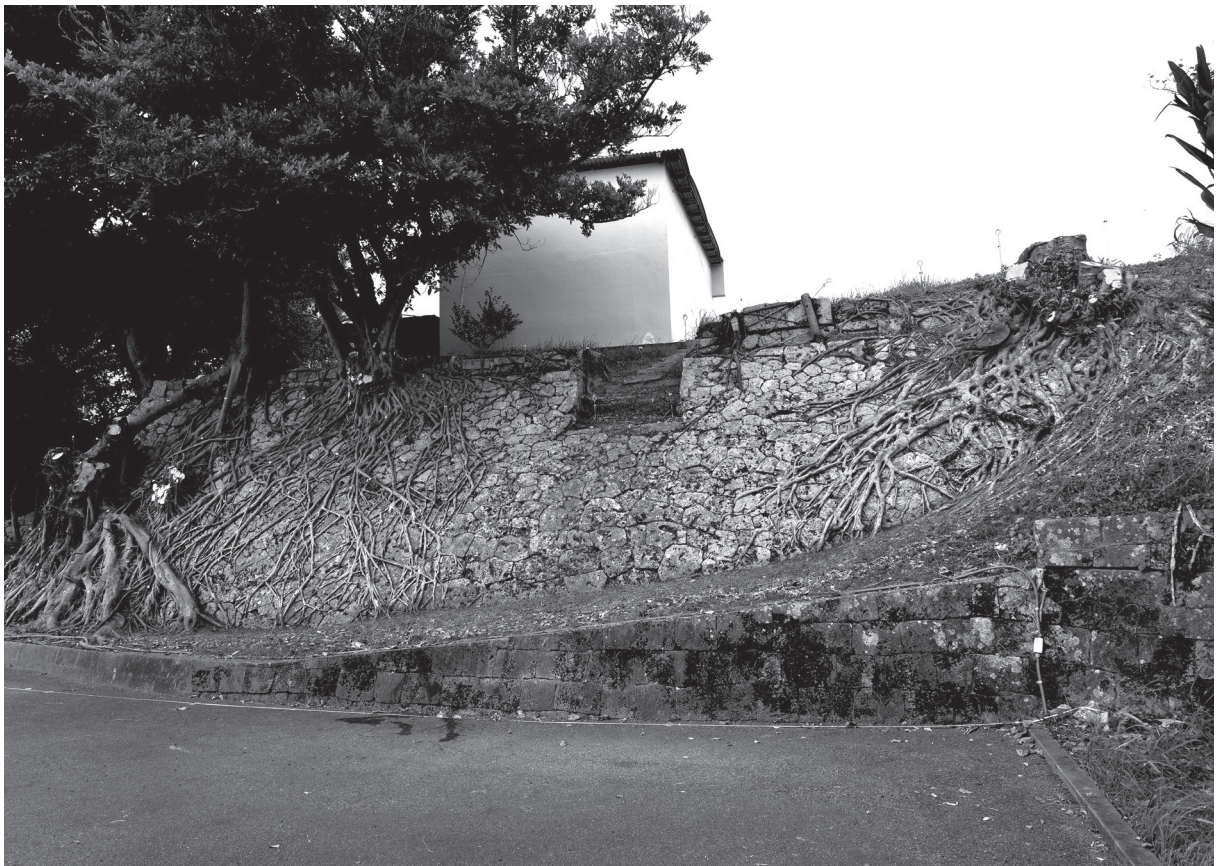
図版 1 石積 A 面の状況 上段：石積 A 面の状況（南西から） 下段：石積 A 面の状況（南から）
