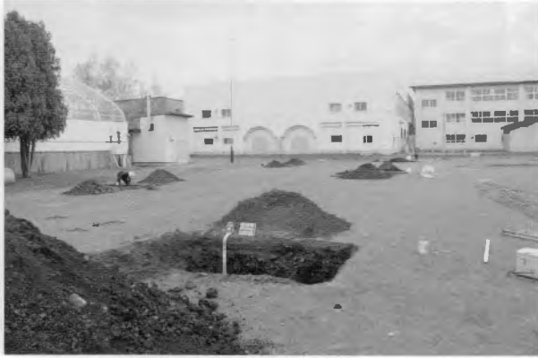
A 事業地近景(北東から)
