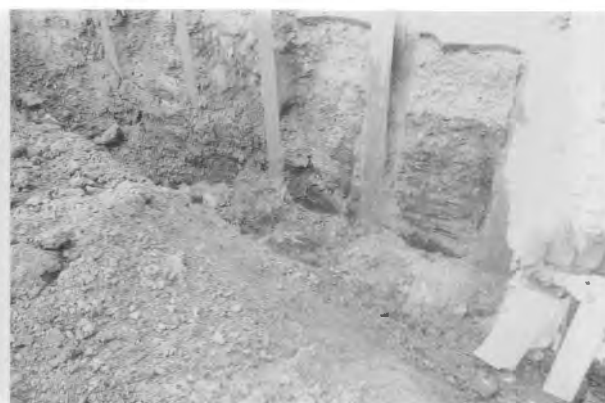
F 工事立会状況
