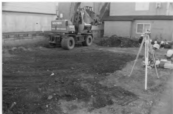
A 事業地近景(北から)
