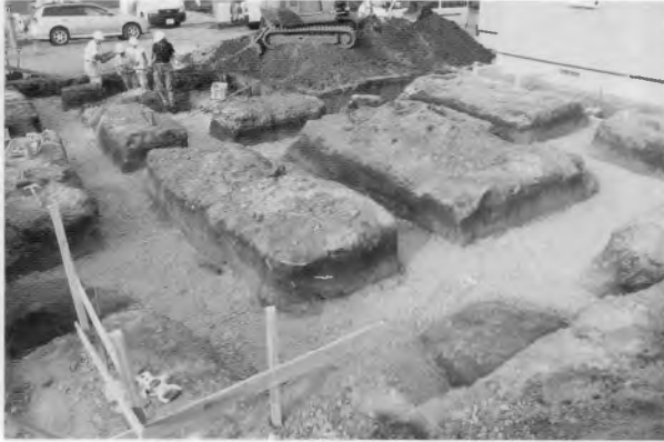
A 工事立会状況
