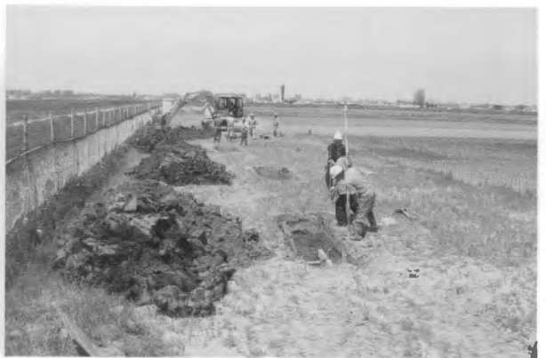
F 調査状況(南東から)
