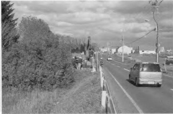
A 事業地近景(南から)
