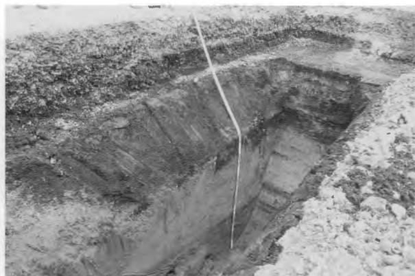
G 工事立会状況
