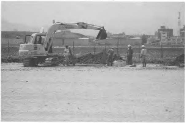
E 調査状況(北東から)
