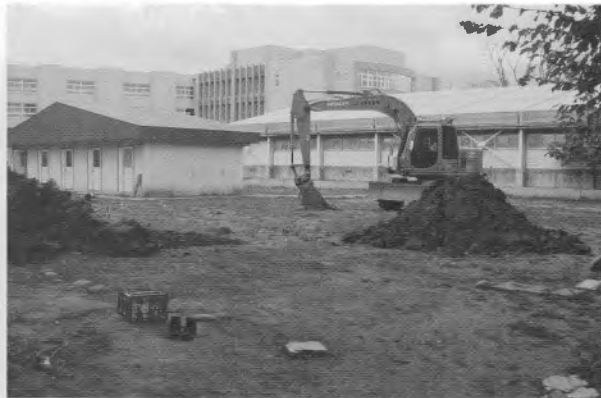
B 事業地近景(北東から)
