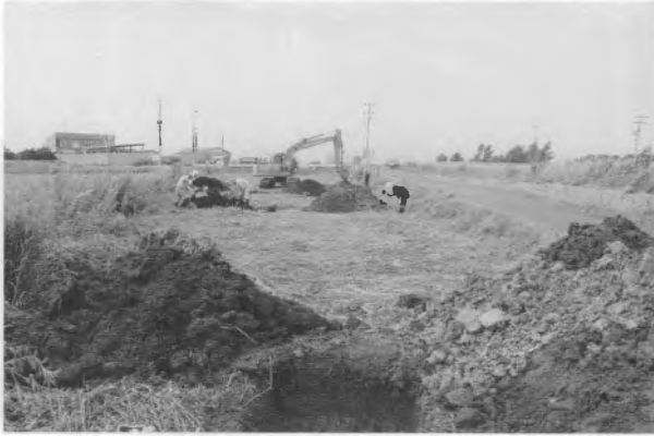
A 事業地近景(北東から)
