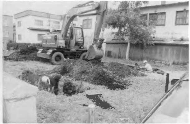
B 事業地近景(南西から)
