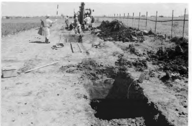
H 調査状況(北西から)
