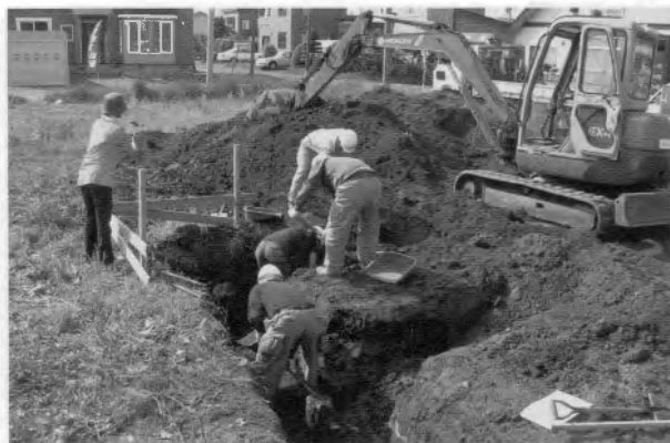
A 工事立会状況(南東から)
