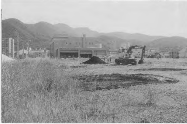
A 事業地近景(北東から)
