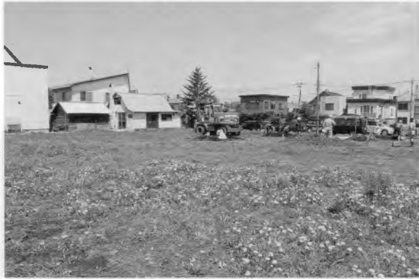
A 事業地近景(北東から)
