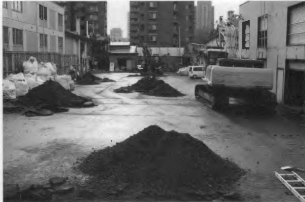
A 事業地近景(北から)
