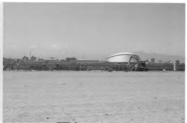
D 調査状況(北東から)
