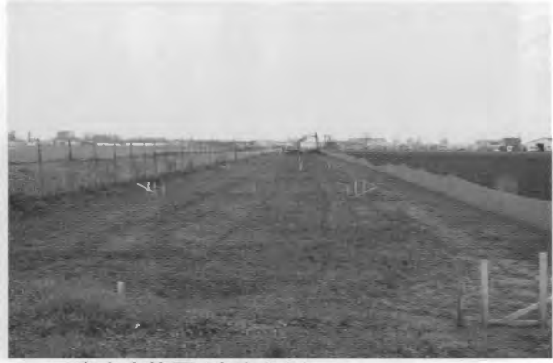
B 工事立会範囲(南東から)
