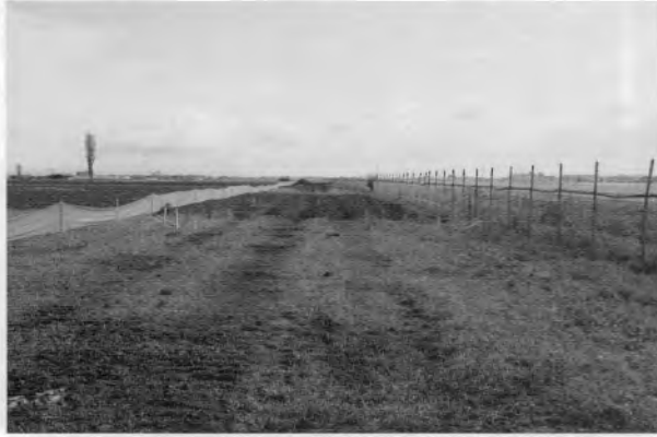
A 工事立会範囲(北西から)
