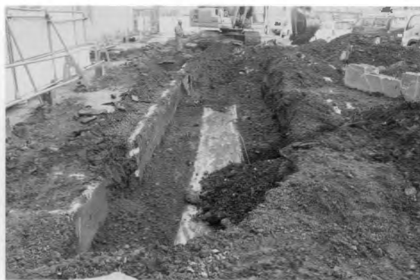
E 工事立会状況
