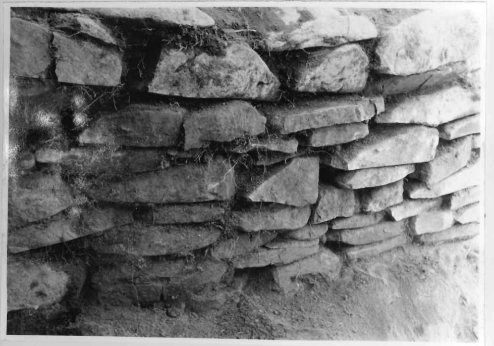
30 玄室奥壁石積みの状態
