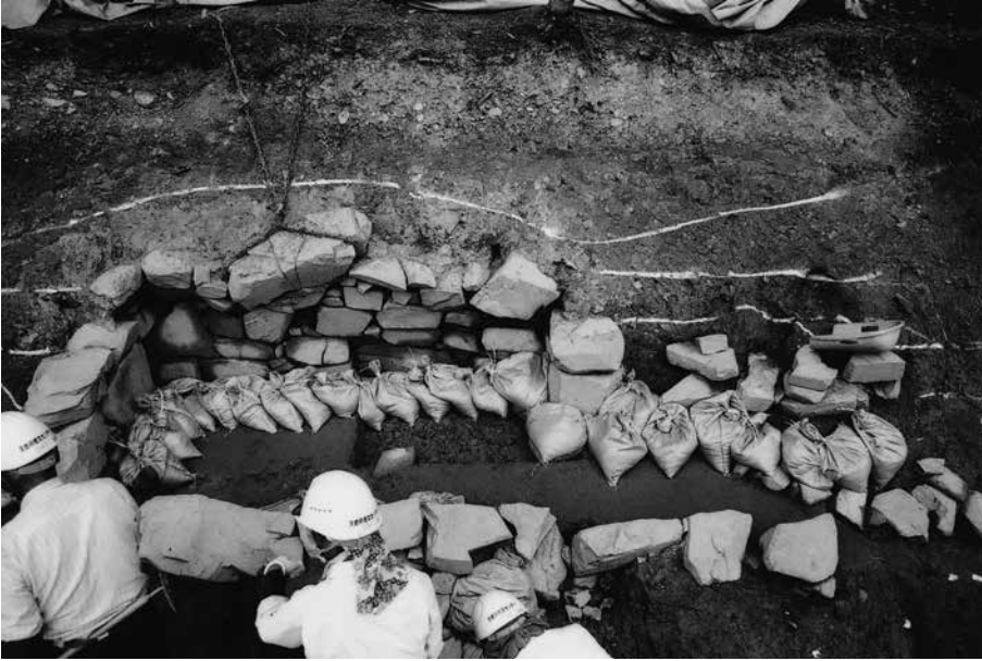
(1) 東光寺古墳 石室養生の作業 状況(西から)
