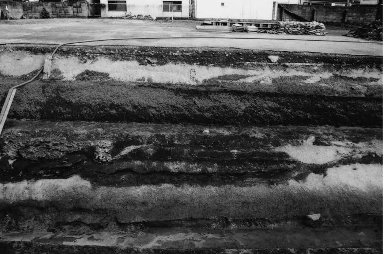
(1) 第 2 トレンチ東壁断面(西から)
