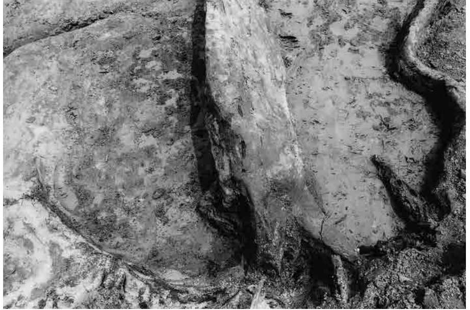
(1) B 地区 S D 22 大形護岸材 E 基部検出状況(西から)
