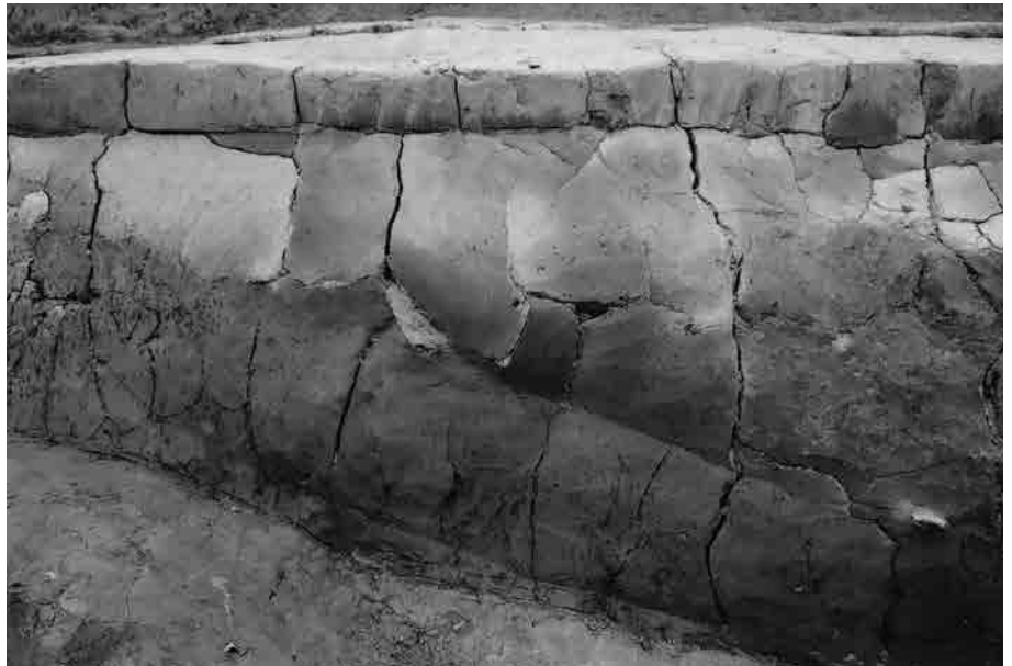
(2) B 地区 S D 22 土層断面 ＜断面 3 北部肩部立ち上がり＞（西から）
