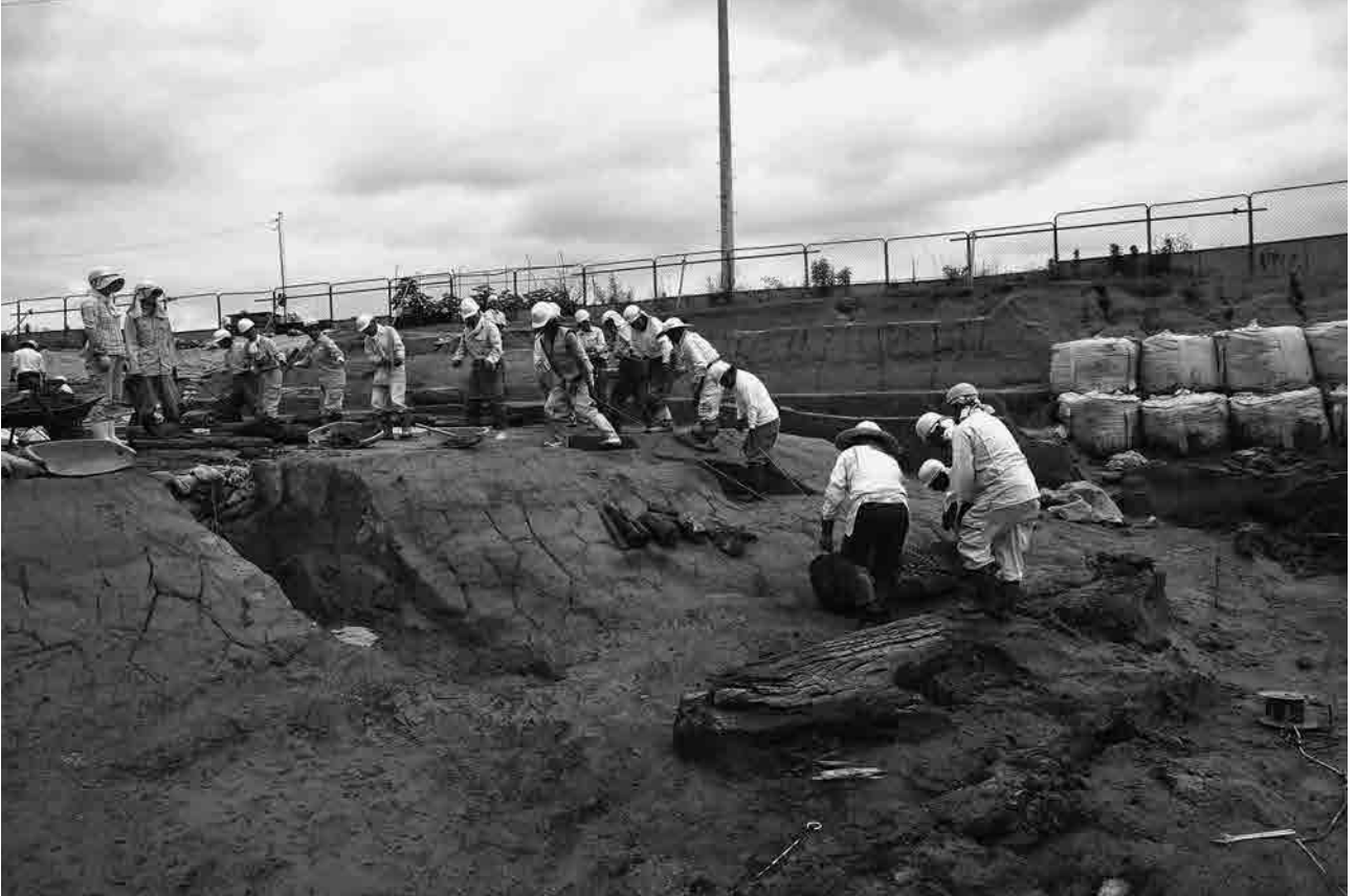
(1) B 地区 S D22 護岸材引き上げ作業(南東から)
