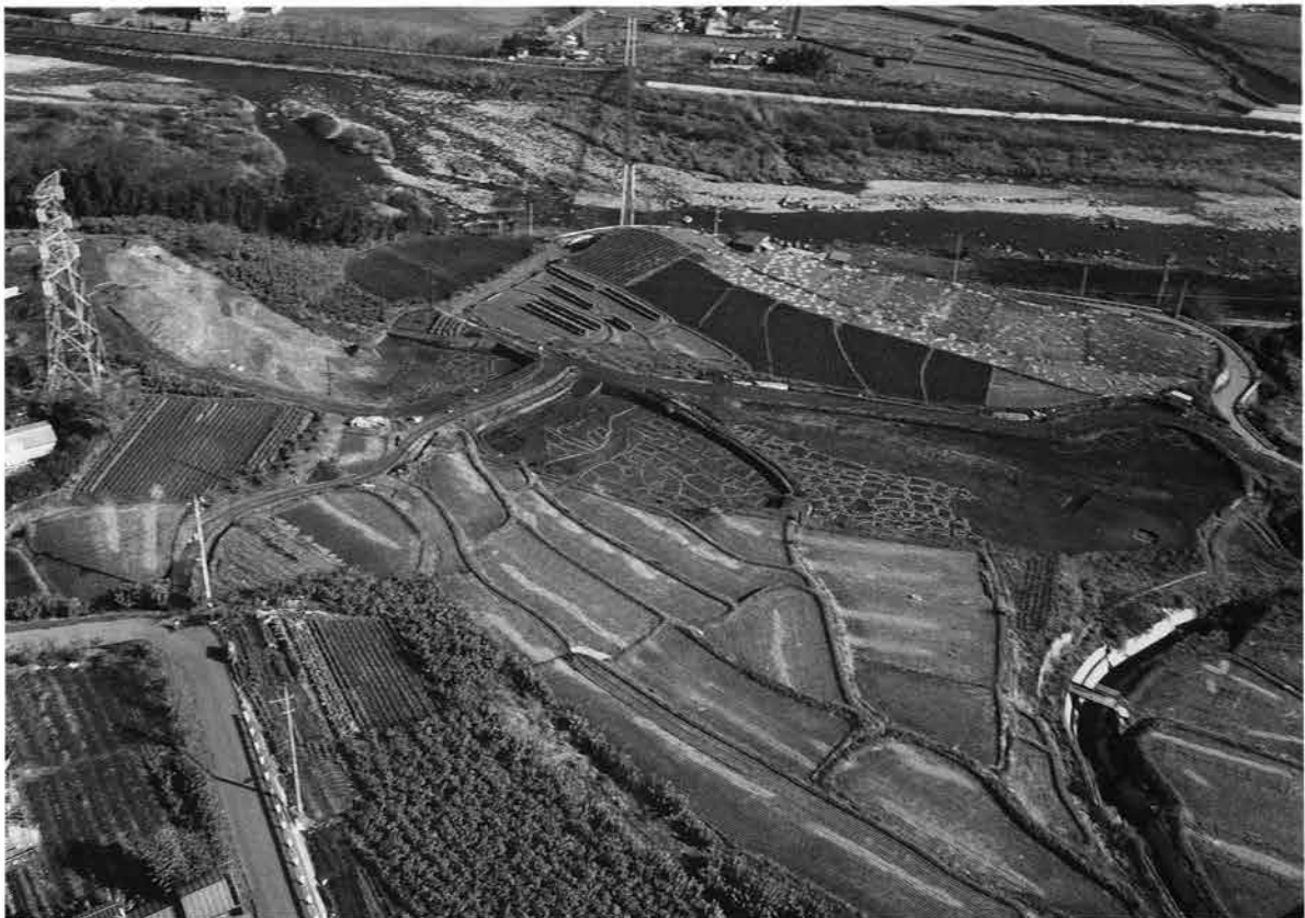
平井地区 FP層下水田跡 全景 (斜め)
