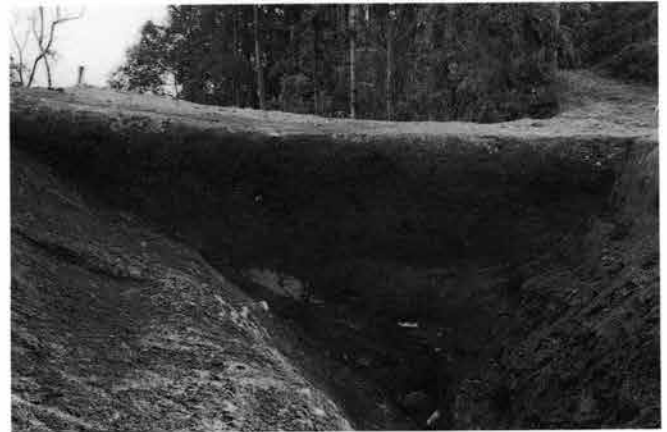
外堀 セクション (西から)
