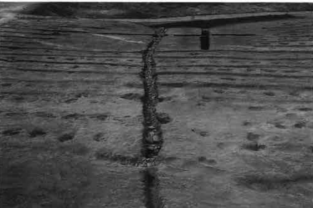
1号暗渠 全景 (東から)
