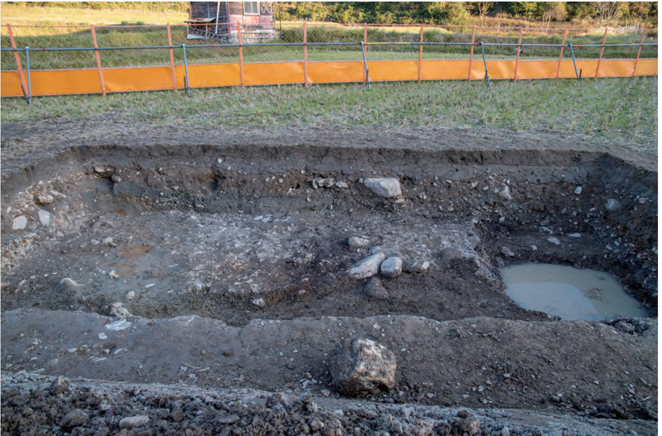
(2) 4トレンチ(西から)
