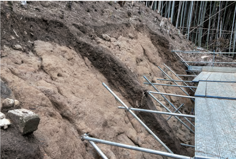
(2) 1区・2区北畔断面土層 (南から)
