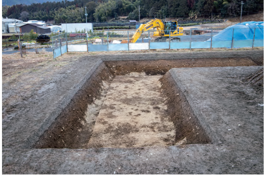
(1) 2区南北部完掘状況(南から)
