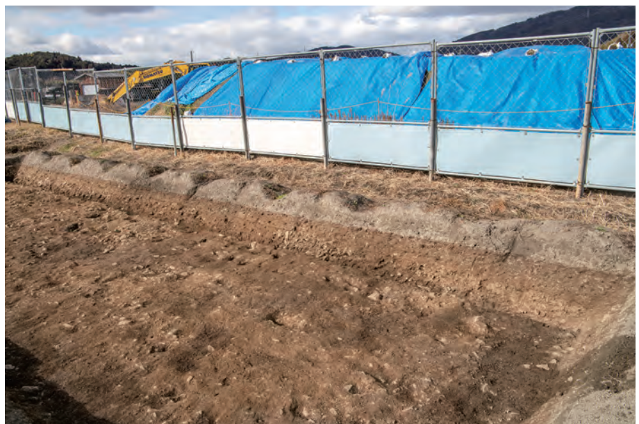
(3) 1区北壁土層断面(南東から)
