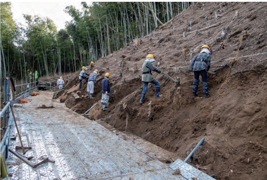
(3) 斜面掘削作業状況(北から)
