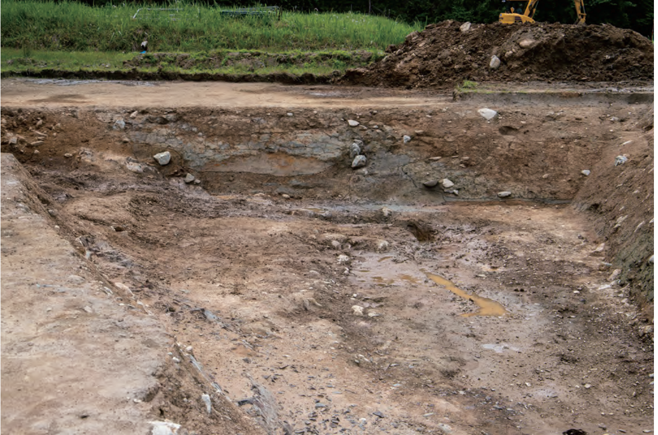
(1) 2 トレンチ南部分 南壁土層断面(北から)
