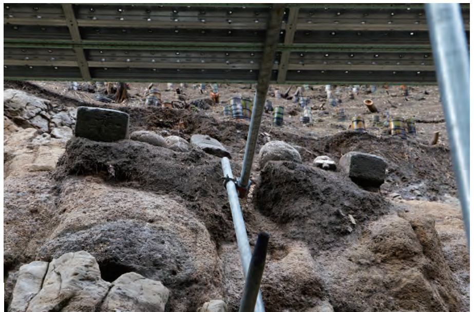
(3) 2区北群石造物群検出状況 (東下方から)
