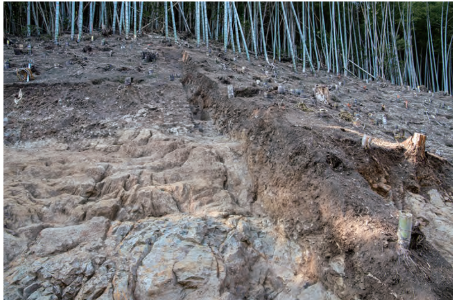
(2) 3区斜面、北端上方断割り 調査状況(東から)
