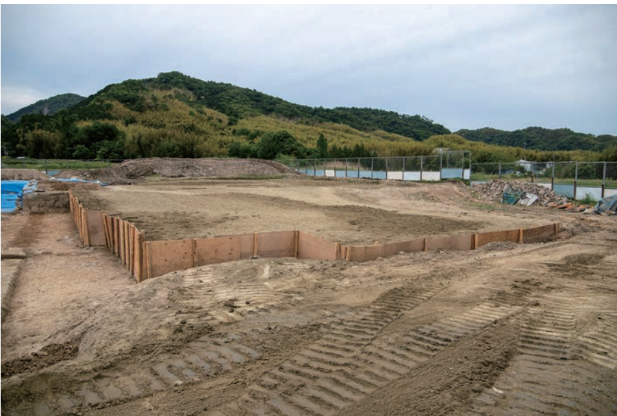
(3) 埋め戻し後状況(北西から)
