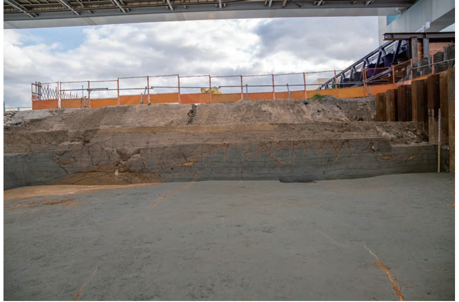
(1) B地区南壁面全景(北から)
