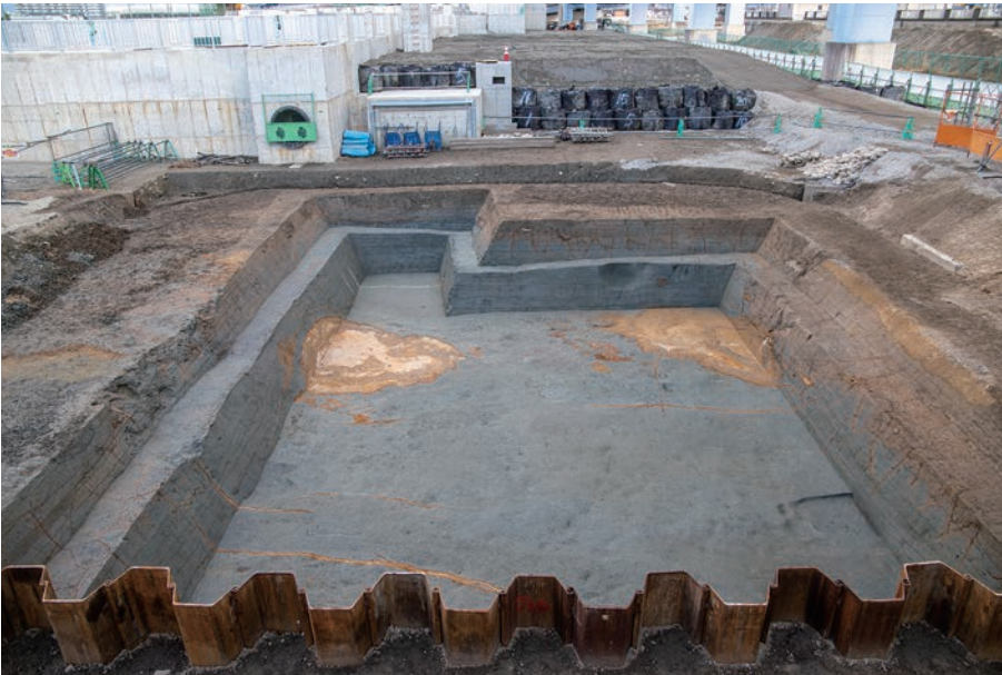
(2) B地区第2面全景(西から)
