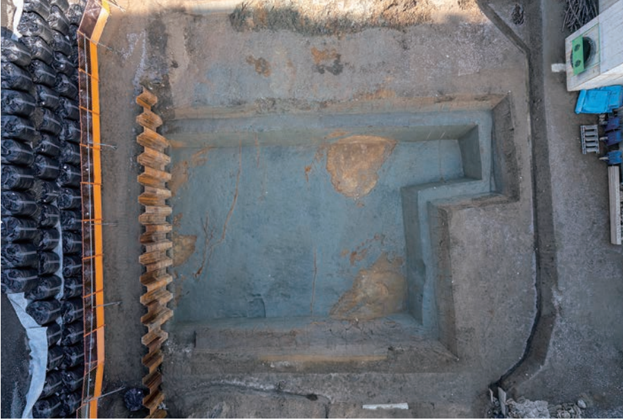
(1) B地区第2面全景(上が北)
