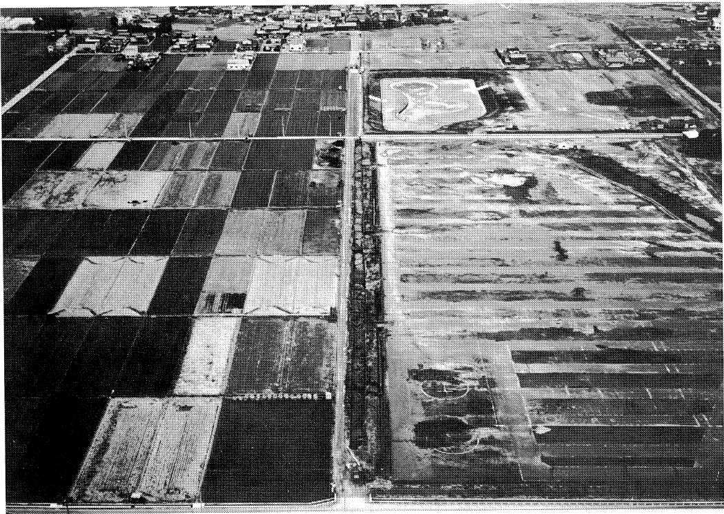
第12地点航空写真（北から）
