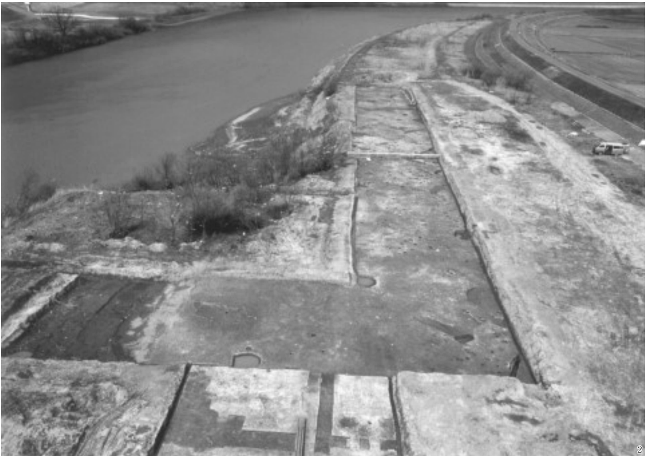
(2) II区遠景（南から）
