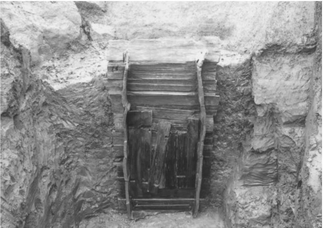
(2) SW1(SL3) 井戸枠解体断面 (北東から)
