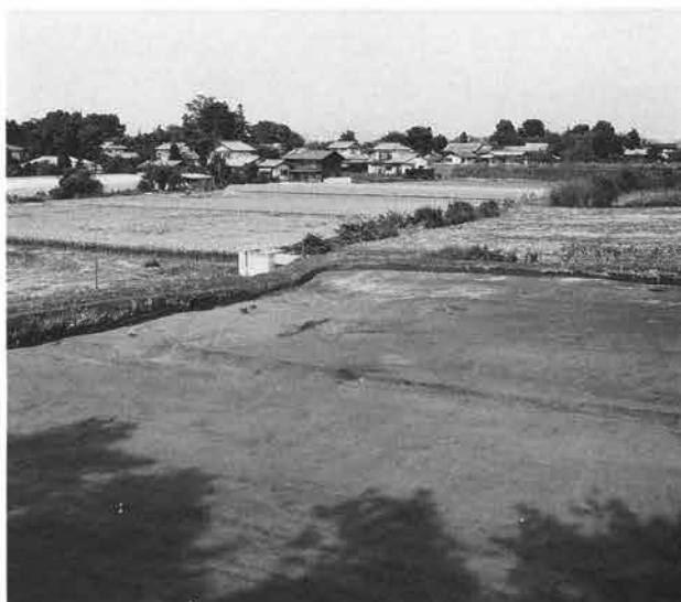
4. A・B区道路状遺構 2 (南側から)
