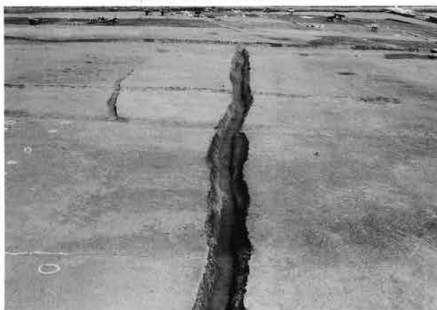
大御堂第19号溝状遺構（南から）
