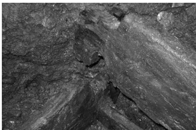
(3) SE04井戸側上段仕口 (南西より)
