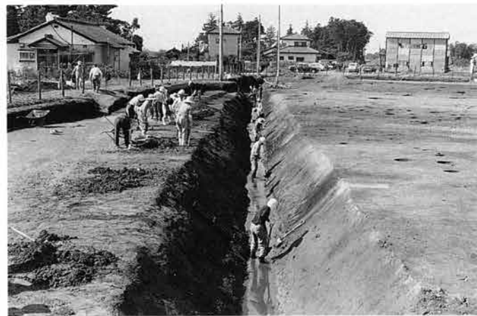
6 17号溝調査状況
