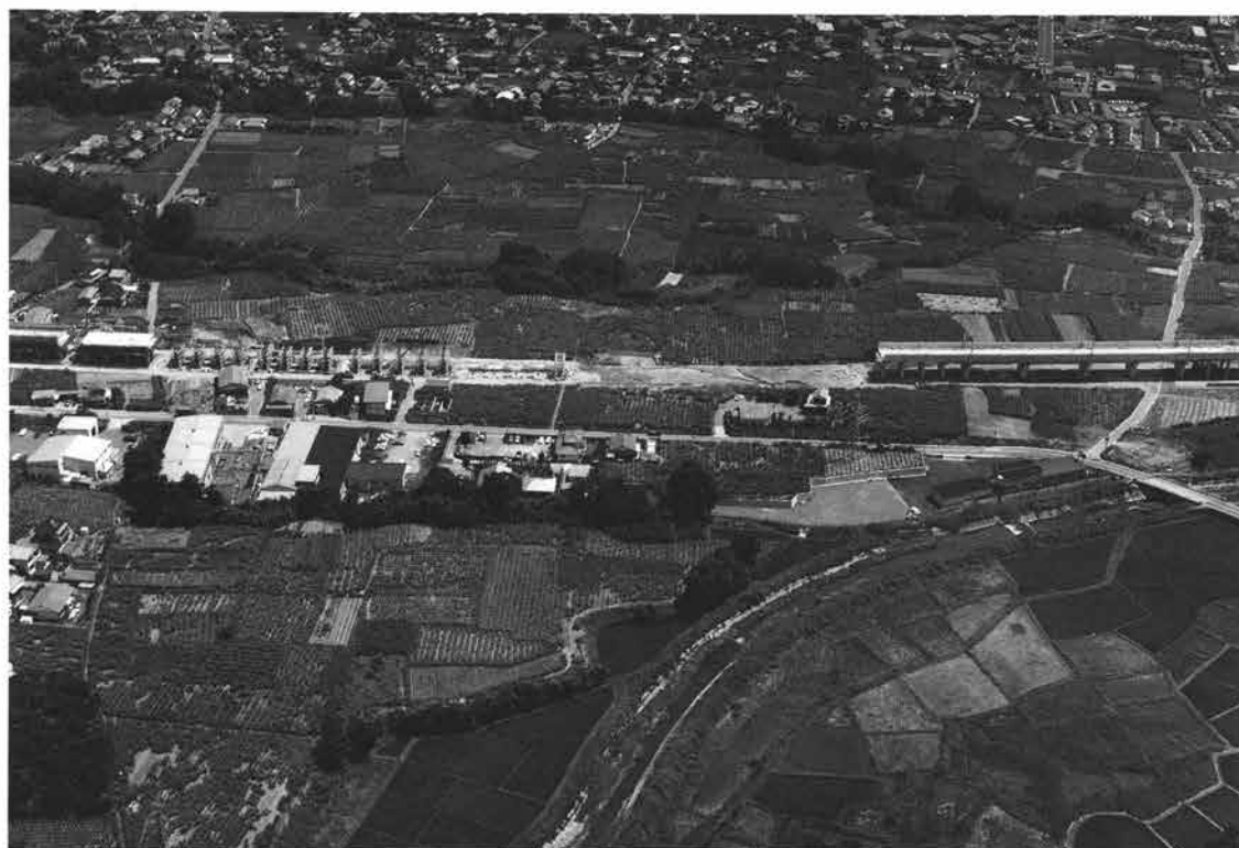
第1地区溜井全景（航空写真 西から）
