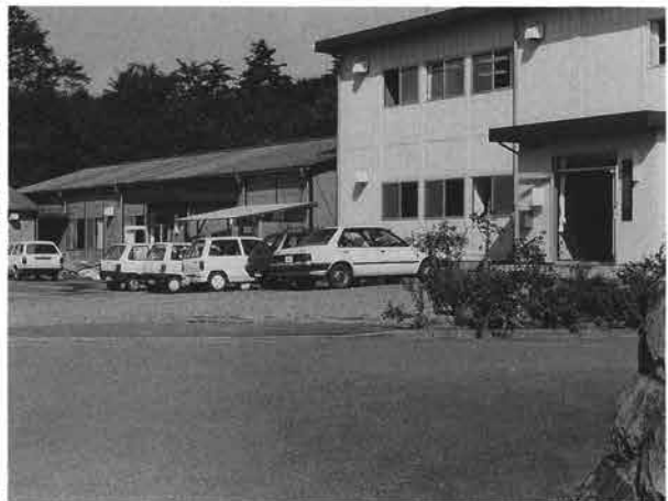
7 上越線調査事務所近景
