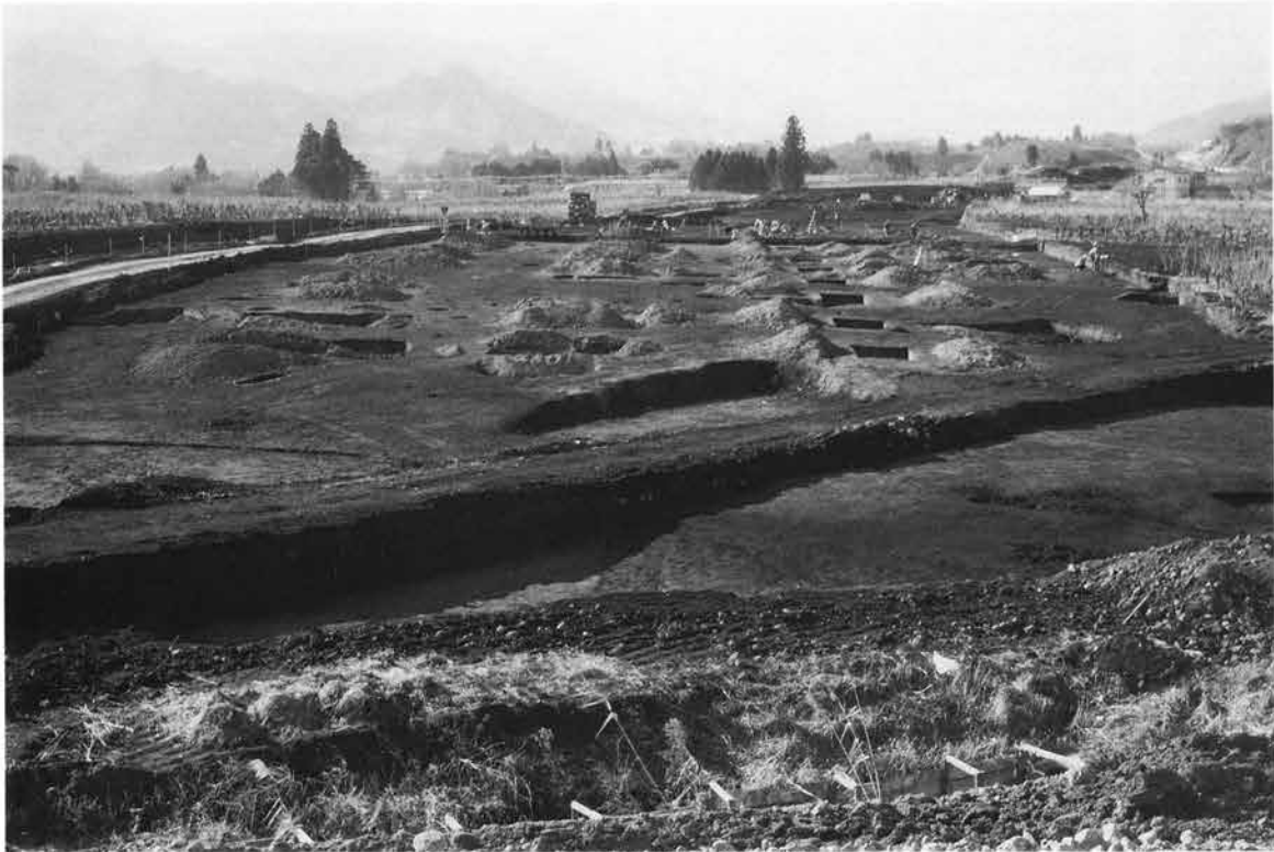
試掘トレンチ設定状態 (遺跡東側)
