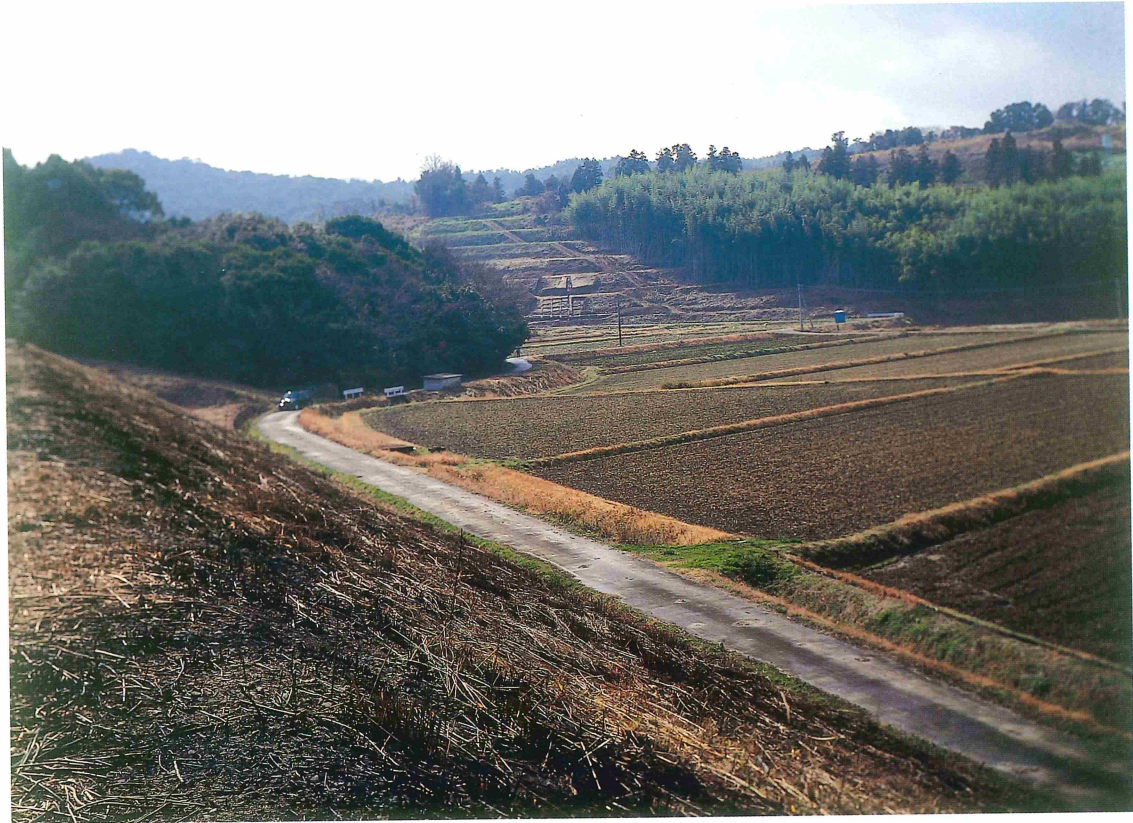
遠景(東方向から)
