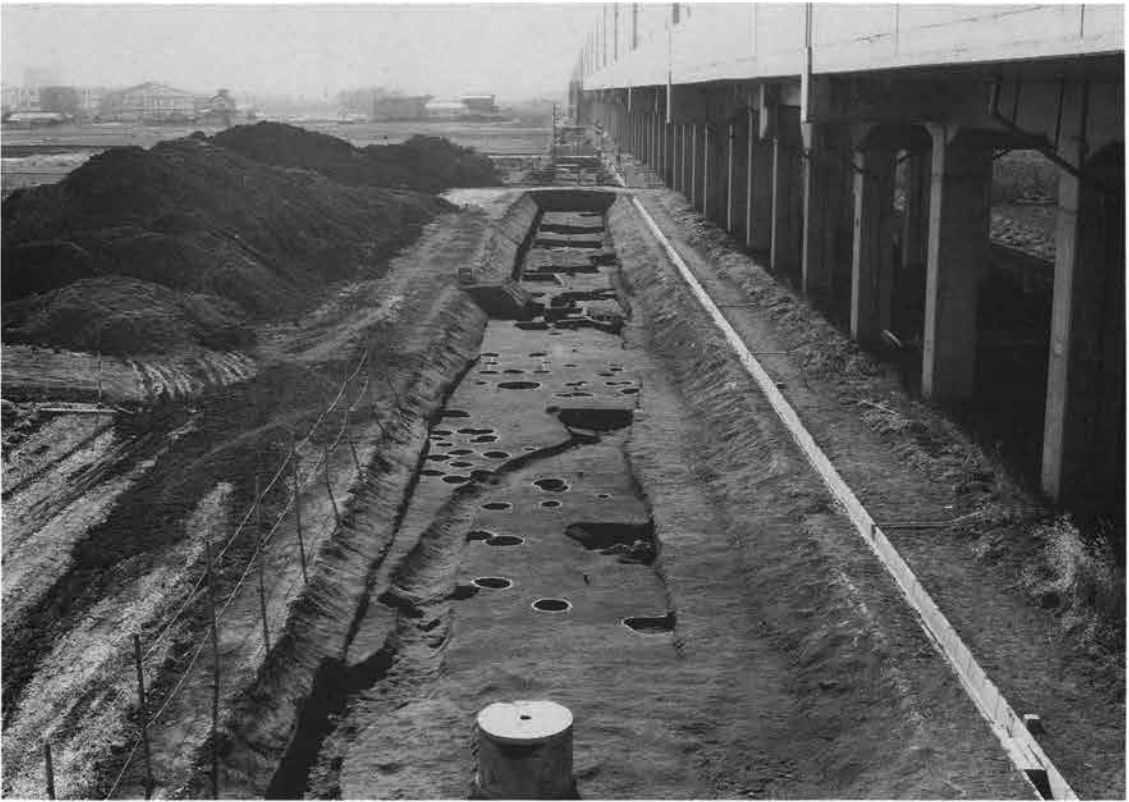
4・5区全景（東側道，北から）
