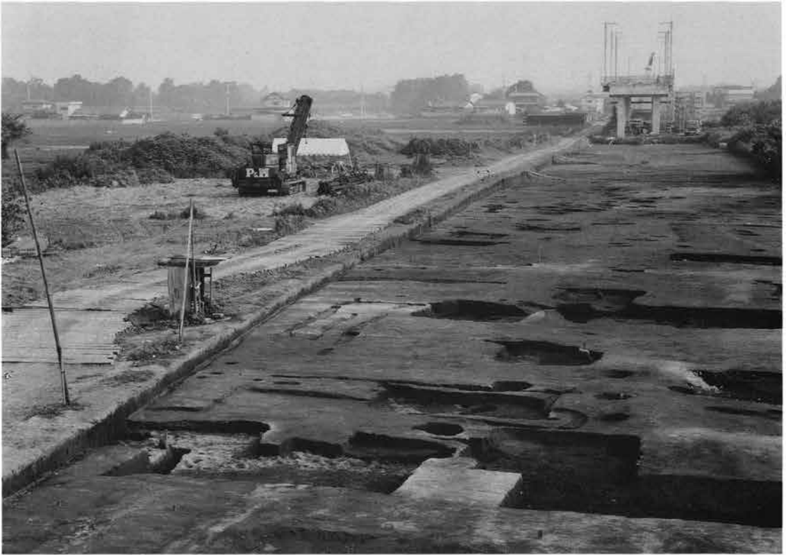
5区東側全景（北から）
