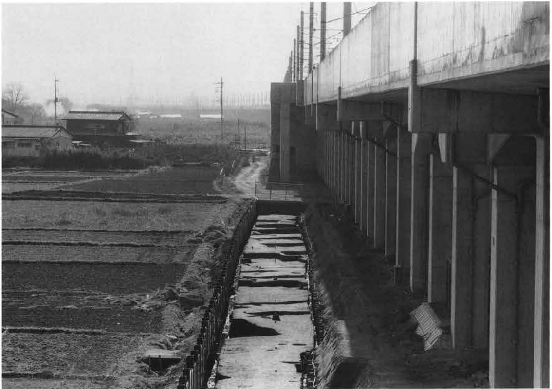
2区南側全景（東側道，北から）
