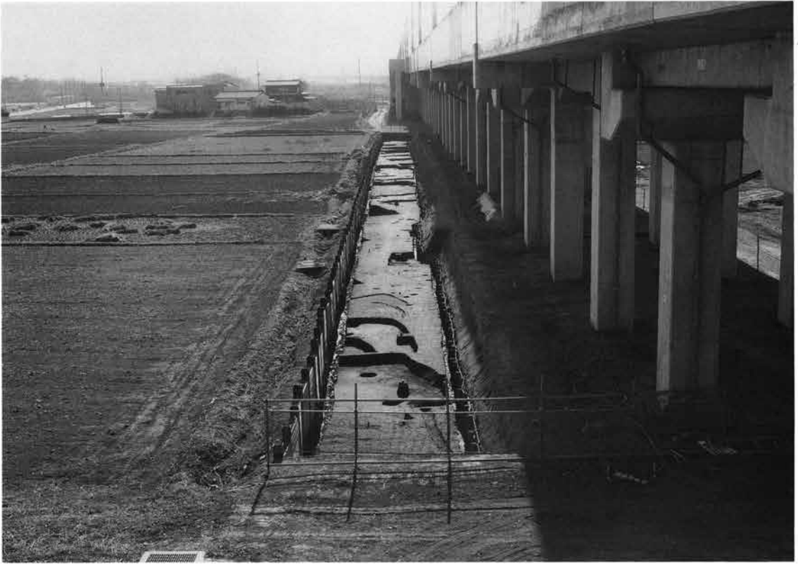
2区掘形全景（東側道，北から）
