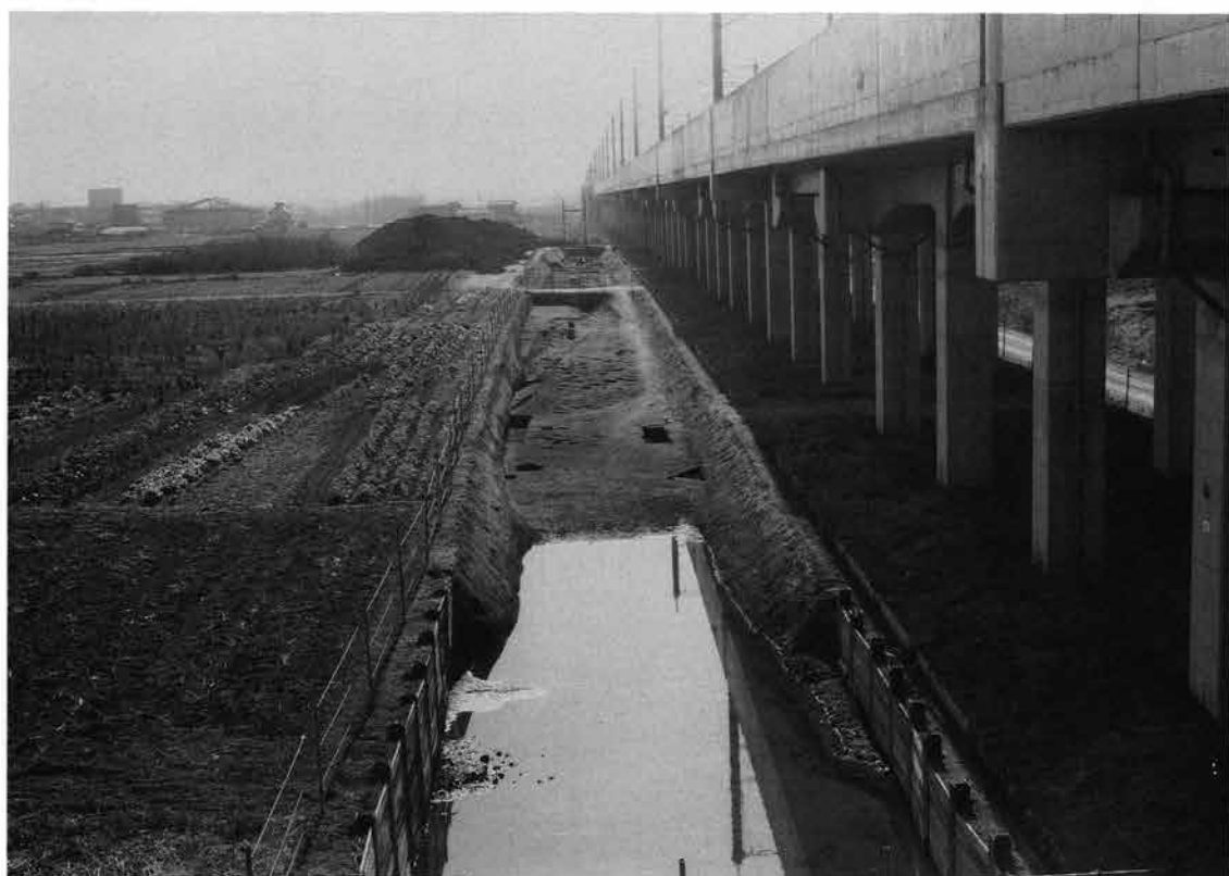
5・6区全景（東側道，北から）
