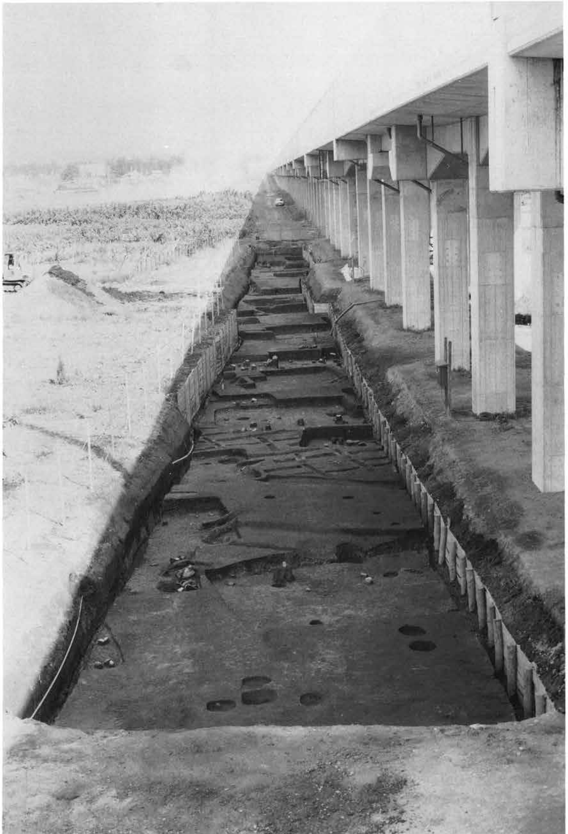
2区全景（西側道，南から）
