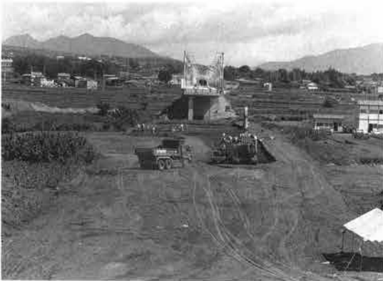
▲5区表土掘削（南から）
