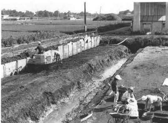
▲3区東壁の土止め工事（北西から）
