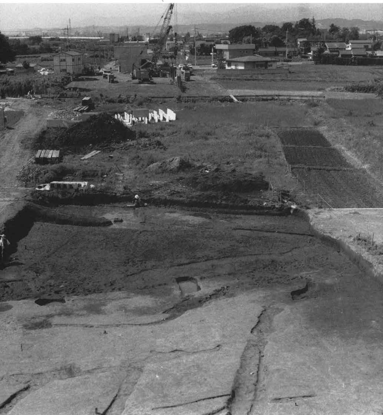
三ツ寺II遺跡から南を望む 手前は三ツ寺II遺跡1区B軽石下水田、奥のクレーンのあるところは三ツ寺I遺跡で安全対策工事中。
