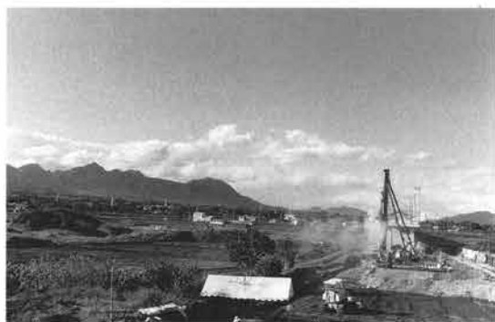
▲6区-5区クイ打ち（南から）
